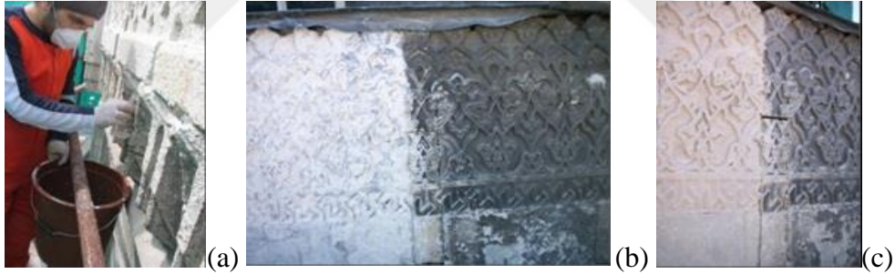
Şekil 17.(a) Kâğıt hamuru uygulaması, (b) kâğıt hamurunun bekletilmesi, (c) temizlenmiş yüzey (Zakar, 2013).
