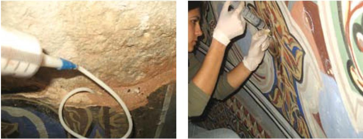
Şekil 31. İstanbul Pertevniyal Valide Sultan Cami, sıva arkası enjeksiyon uygulaması (Çebi, 2010).
