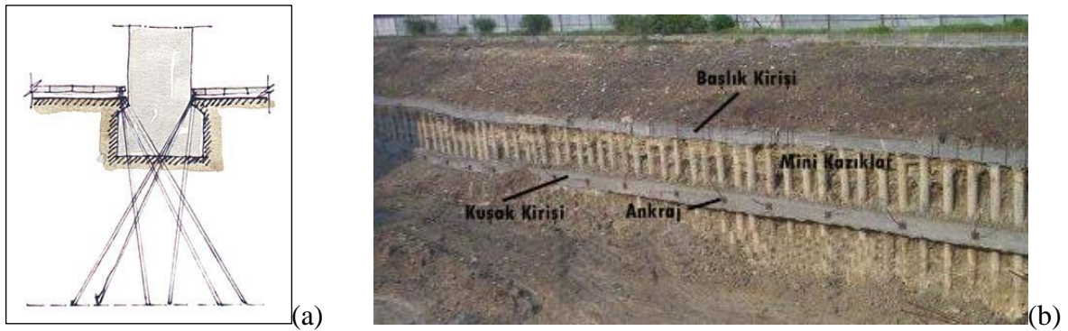
Şekil 34.(a) Mikro kazık uygulaması (Zakar, 2013), (b) mikro kazık uygulaması (URL-11).
