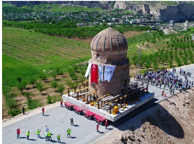
Şekil 35. Batman Zeynel Bey Türbesi'nin taşınması (URL-12).
