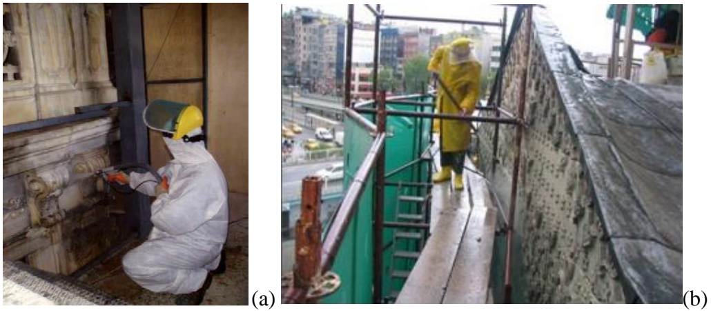
Şekil 18. (a), (b) Taş yüzeyde basınçlı su ile yıkama (Zakar, 2013).
