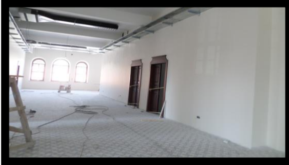
Şekil 6. Kayseri Lisesi yeniden işlevlendirme uygulama öncesi (Sel.2018)
