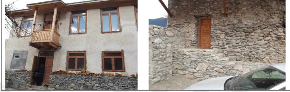
Şekil 8. 1 nolu Svan Evi giriş cephesi
