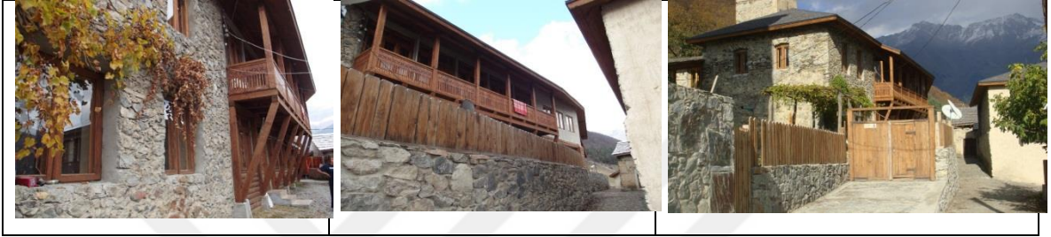
Şekil 30. 4 nolu Svan Evi görünüşleri
