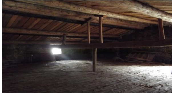
Şekil 41. 5 nolu Svan Evi çatı katı tavan görünüşü
