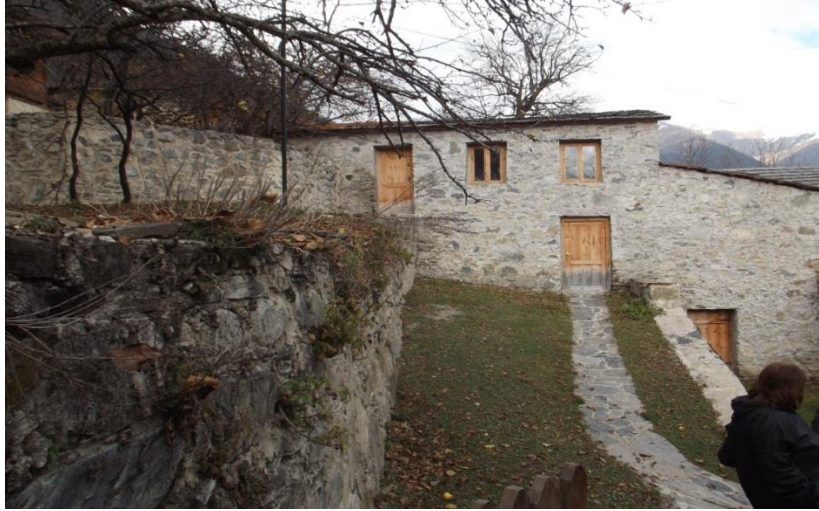
Şekil 35. 5 nolu Svan Evi giriş cephesi görünüşü
