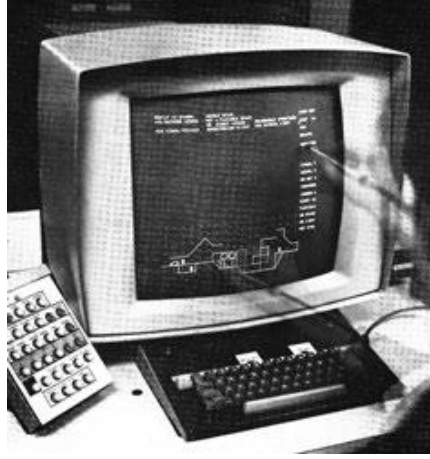
Şekil 8. URBAN 5'in örtüsü ve URBAN 5'te kullanılan IBM 2250 model 1 katot ışın tüpü (Vardouli, 2012)
