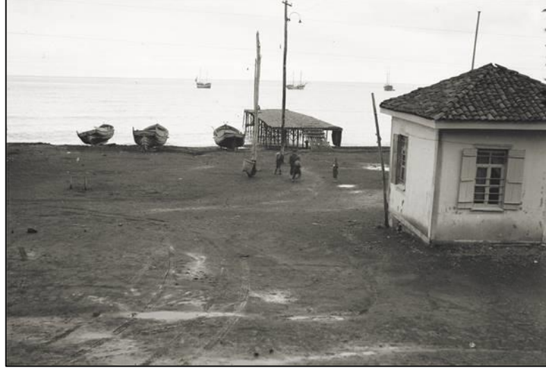
Şekil 134. Diğer Gümrük Binası, ahşap iskelenin yanında, 1930'lar (Bölükbaşı, 2010)
