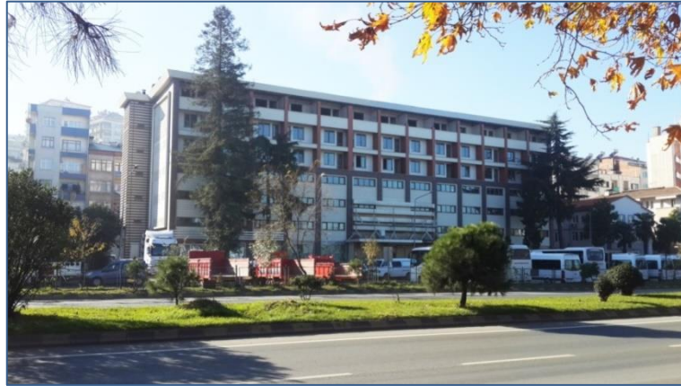
Şekil 89. 5 numaralı blok kuzey cephesi, günümüz (Üçüncü, 2016)
