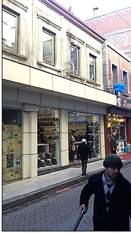
Şekil 103. Medrese-i Kebir Binası İstiklal Caddesi cephesi, günümüz (Üçüncü, 2016)
