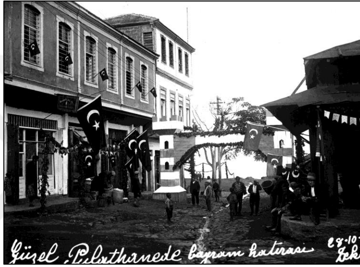
Şekil 45. Akçaabat Çarşı Bölgesi zemin kat kargir, diğer katlar bağdadi yapım sistemli yapılar, 1933 yılı (Bölükbaşı, 2010)
