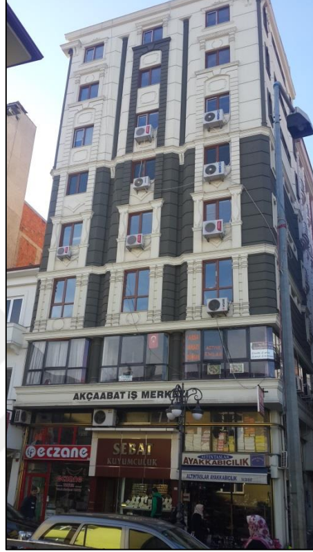
Şekil 136. Yıkılan Gmrk Binası'nın yerine yapılan yapı İnn Caddesi cephesi, gnmz (nc, 2016)
