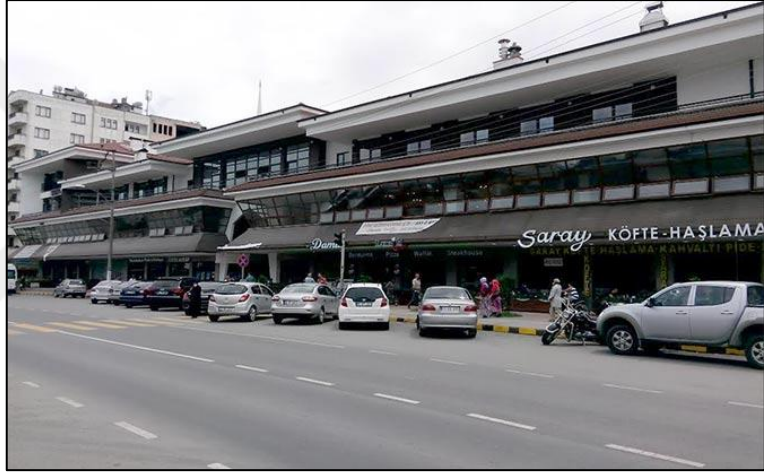
Şekil 152. Hamam Çimeni Çarşısı kuzey cephesi, günümüz (Üçüncü, 2016)
