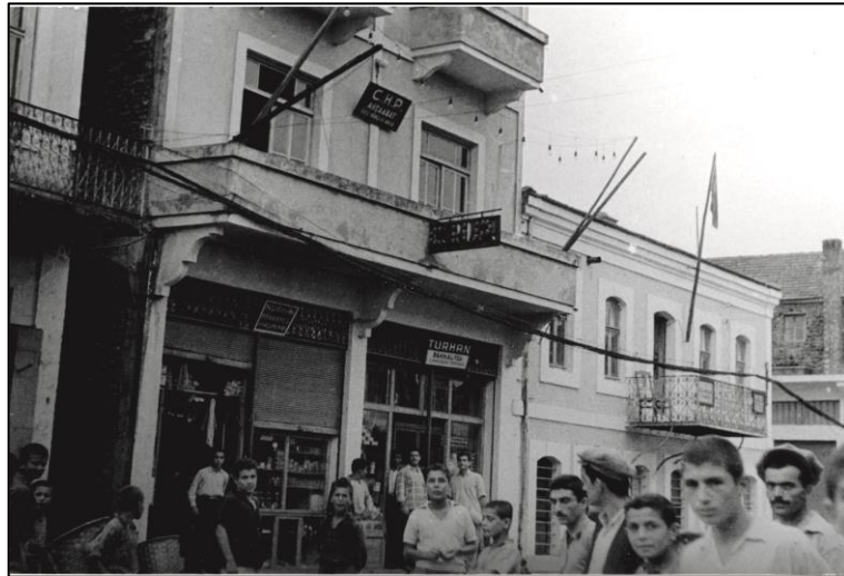
Şekil 46. Akçaabat Çarşı Bölgesi solda betonarme, sağda yığma kargir yapım sistemli yapı, 1960 sonları (Bölükbaşı, 2010)
