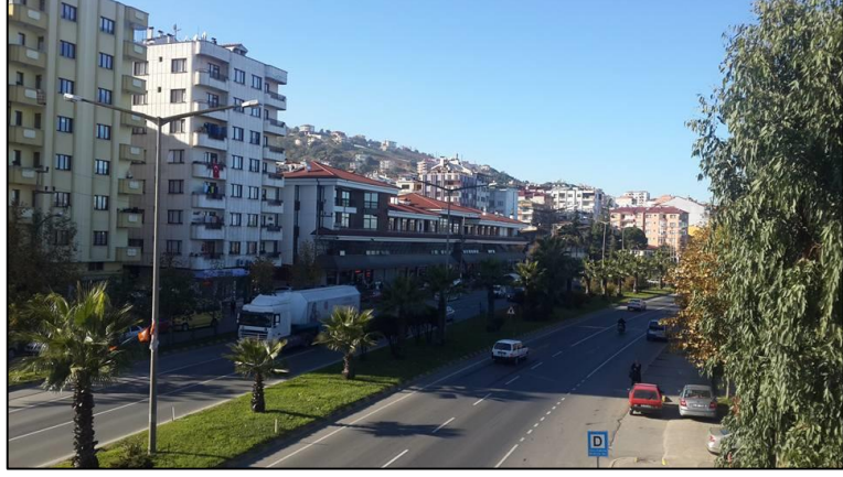
Şekil 151. Hamam Çimeni Çarşısı kuzey cephesi, günümüz (Üçüncü, 2016)
