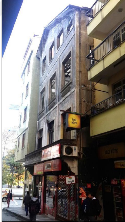
Şekil 132. 2016 yılı, yıkılan Hacıömeroğlu Binasından kalan son kısım (Üçüncü, 2016)
