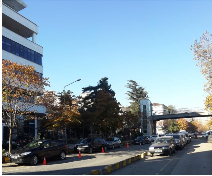
Şekil 146. Akçaabat Belediyesi Hizmet Binası ve Atatürk Parkı kuzey cephesi, günümüz (Üçüncü, 2016)
