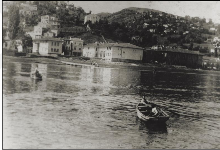
Şekil 138. Halkevi Binası kuzey cephesi, 1950 yılı ortaları (Bölükbaşı, 2010)
