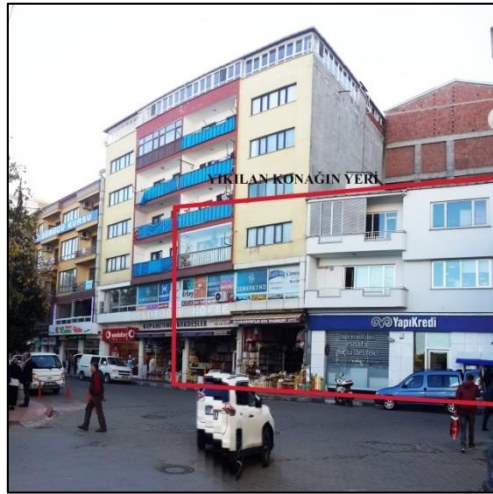
Şekil 123. Hacıömerođlu Binası yerine yapılan yapıların İnönü Caddesi cephesi, günümüz (Üçüncü, 2016)
