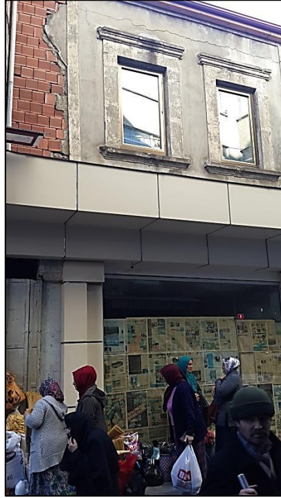
Şekil 104. Medrese-i Kebir Binası İstiklal Caddesi cephesi, günümüz (Üçüncü, 2016)
