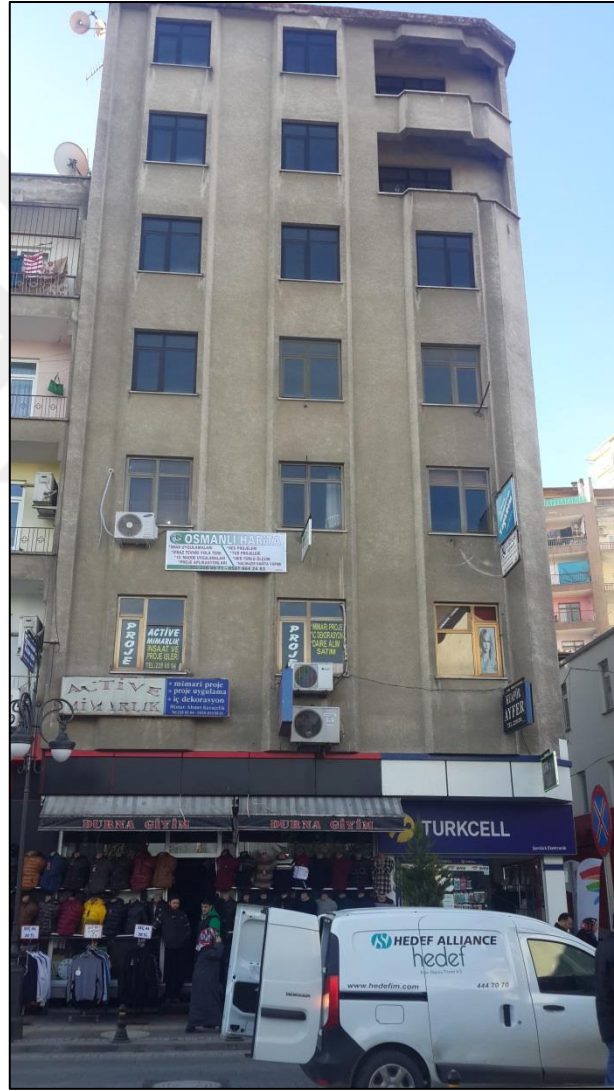
Şekil 112. Topsakal’ın Kahvesi’nin yerine yapılan yapının İnönü Caddesi cephesi, günümüz (Üçüncü, 2016)
