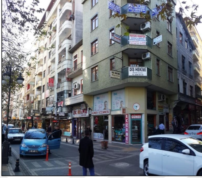
Şekil 131. Yıkılan Başaran ve Hacıömeroğlu Binaları yerine yapılan yapıların İnönü Caddesi cepheleri, günümüz (Üçüncü, 2016)
