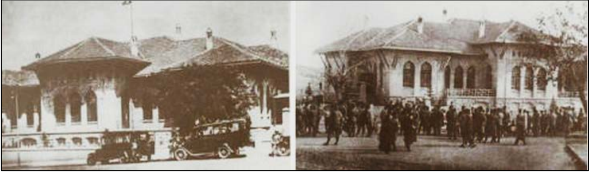
Şekil 3. Birinci Büyük Millet Meclisi Binası (URL-1, 2015)
