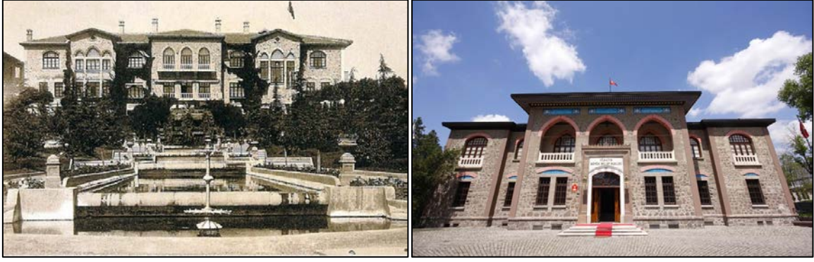
Şekil 4. İkinci Büyük Millet Meclisi Binası geçmiş ve güncel fotoğrafları (URL-2, 2015; URL-3, 2015)
