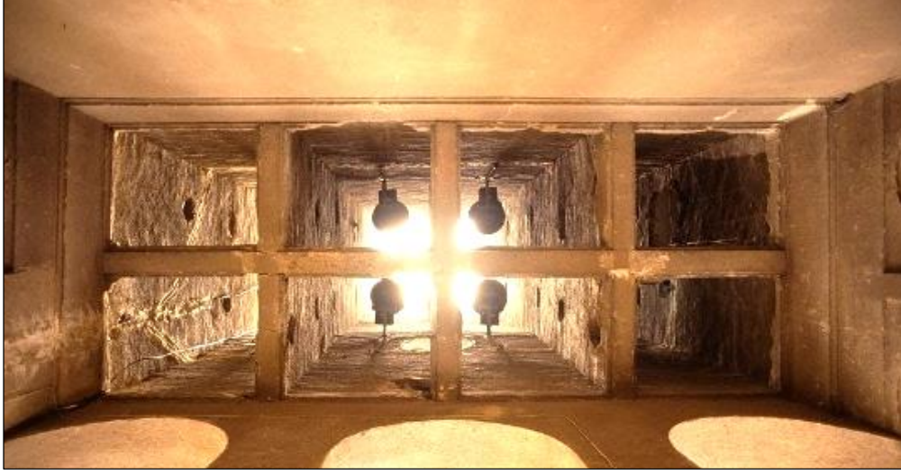
Şekil 25. Sekiz bölmelere ayrılan rüzgar kulesi
