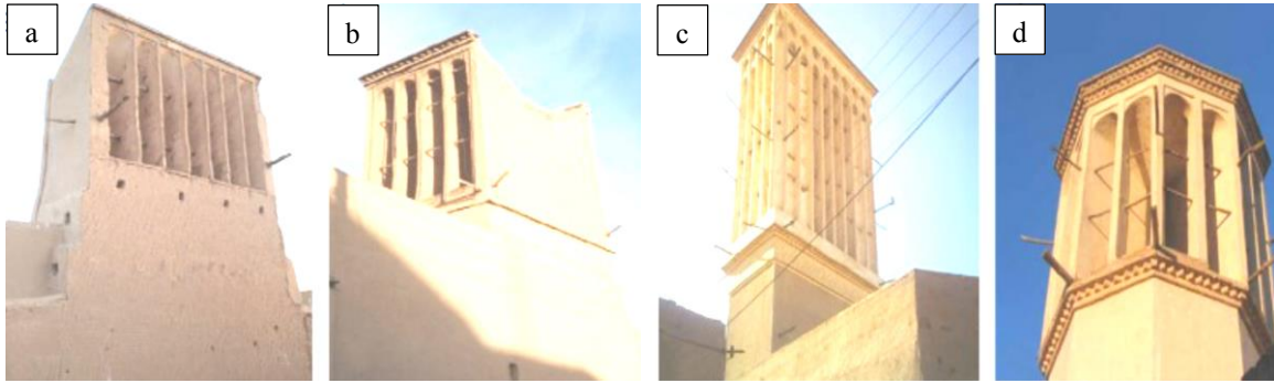
Şekil 24. Rüzgar kulelerinde farklı bacalar; bir yönlü (a), iki yönlü (b), dört yönlü (c), sekiz yönlü (d) (Mourad, 2014).
