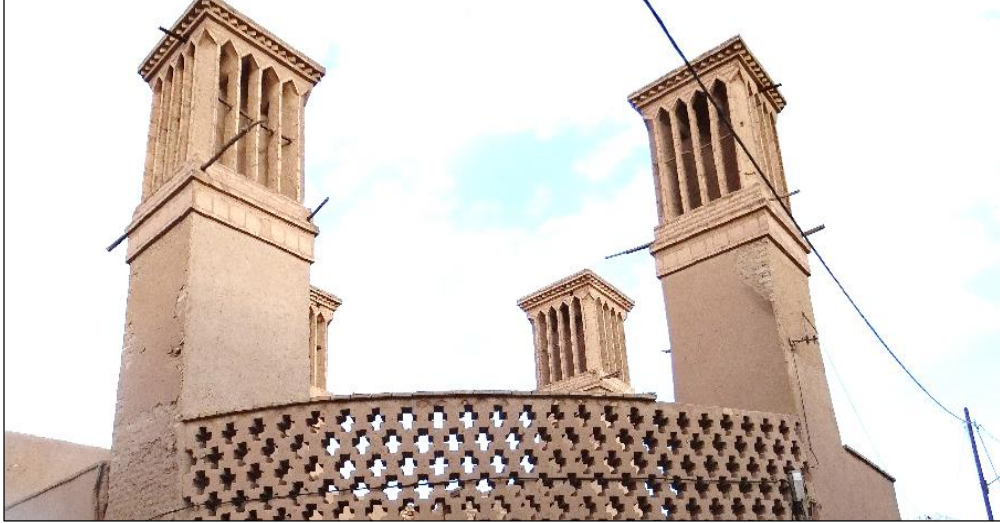
Şekil 10. Yazd kentinde kullanılan rüzgar kuleleri
