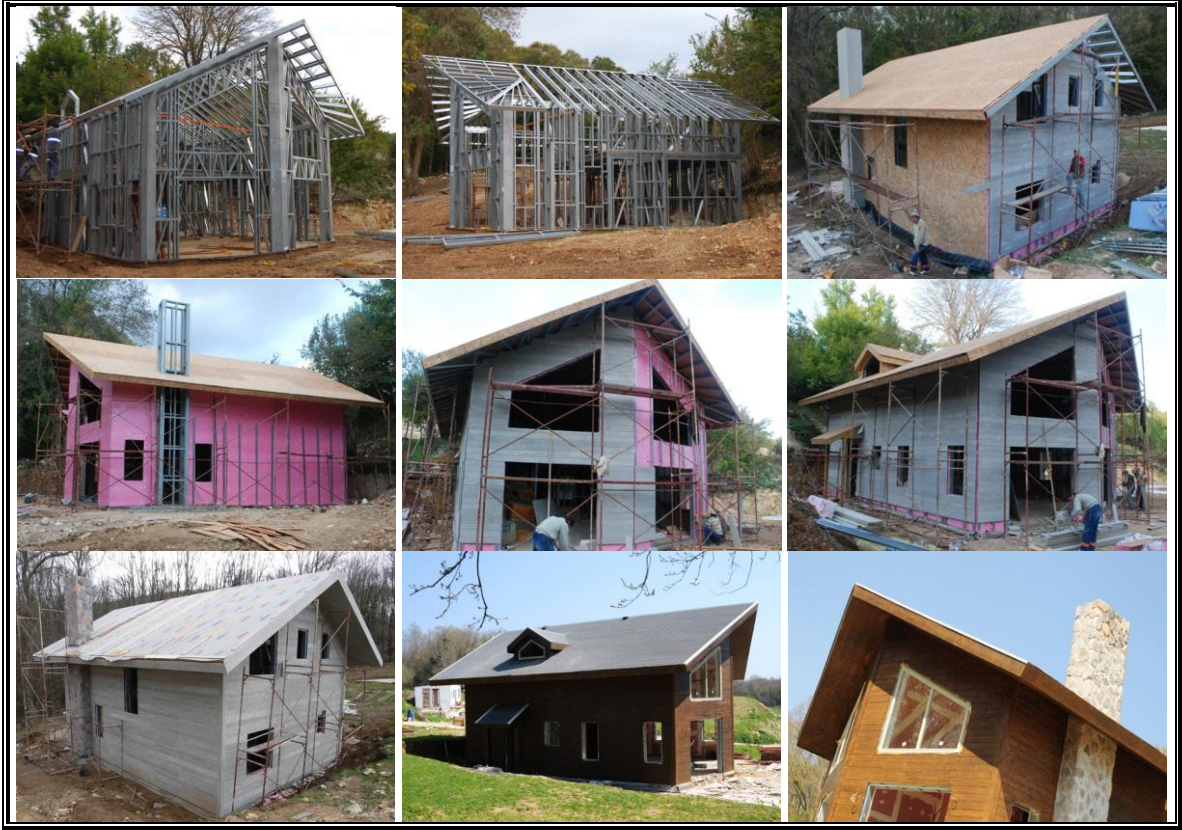
Şekil 40. Hafif çelik yapı sistemi örnekleri (URL-8, 2013).
