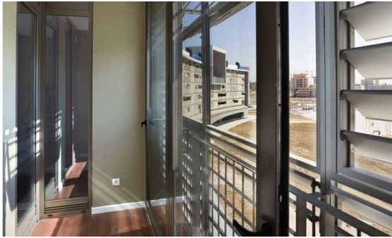
Şekil 31. Güneş odalı apartman kompleksinde güneş kontrolünü sağlayan güneş kırıcılar (URL-8, 2013)
