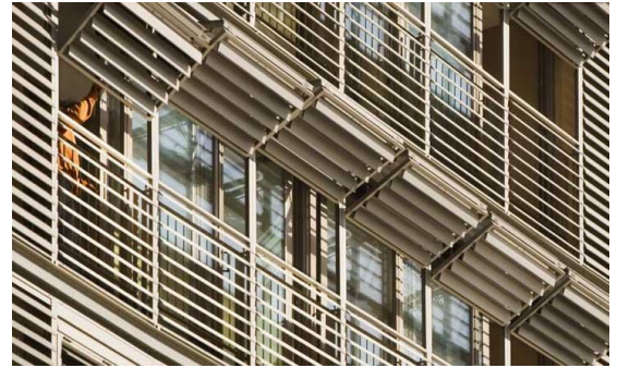
Şekil 31. Güneş odalı apartman kompleksinde güneş kontrolünü sağlayan güneş kırıcılar (URL-8, 2013)
