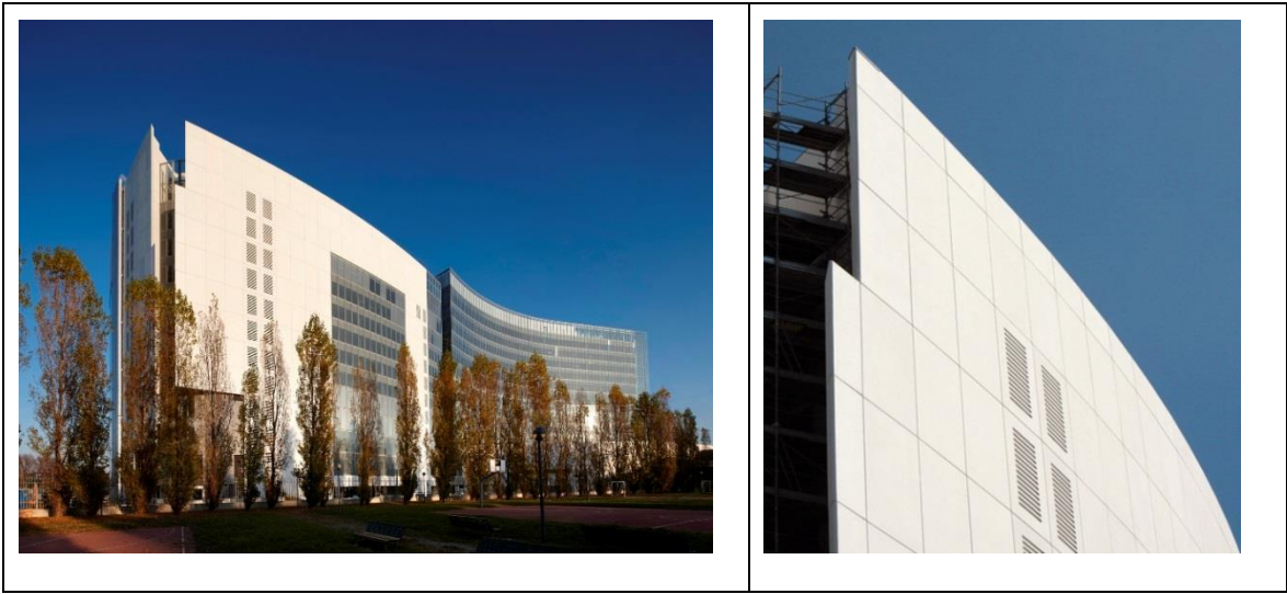
Şekil 2.26. Vodafone Ofis Binası, Milano- İtalya[97].
