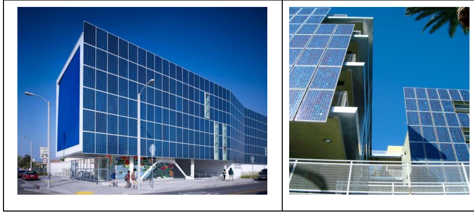
Şekil 2.72. Fotovoltaik panellerin cephede kullanımına yönelik örnekler[187, 188].
