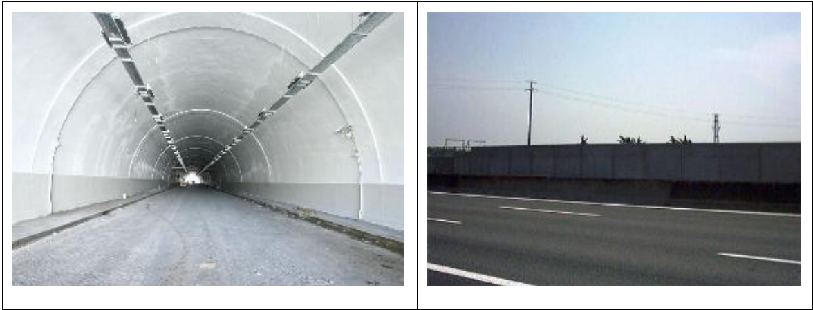
Şekil 2.28. Umberto-I tüneli ve beton gürültü duvarları, Roma-İtalya[99].
