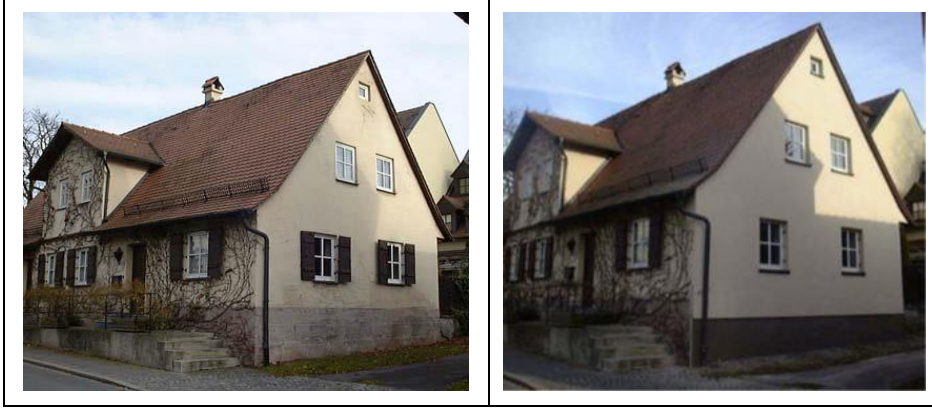
Şekil 2.63. Vakumlu ısı yalıtım uygulanmasından öncesine ve sonrasına ait görünüm[168].
