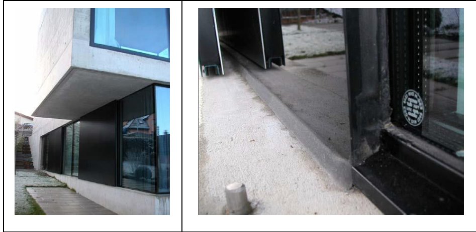
Şekil 2.65. VYP uygulanmış yapıya ait cephe görüntüleri [168].
