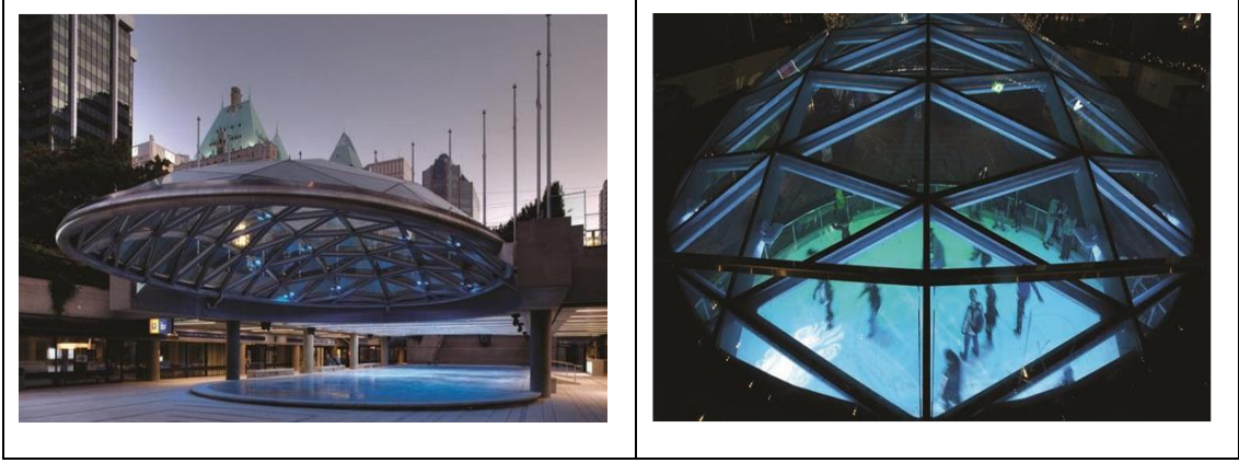
Şekil 2.20. Ge Plaza Kubbesi, Vancouver-KANADA[92].
