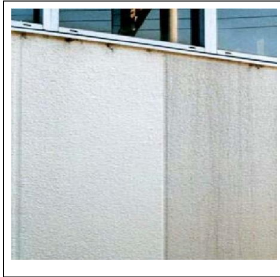
Şekil 2.25. Fotokatalitik etkiye sahip nanokaplama uygulanmış ve uygulanmamış beton yüzey [3].
