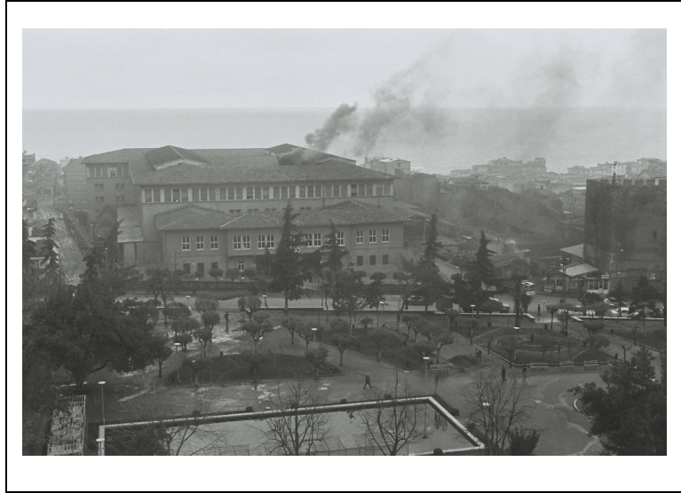
Şekil 3. Tekel Binası'nın Atapark yönünden görünümü (Sümerkan, 1974).
