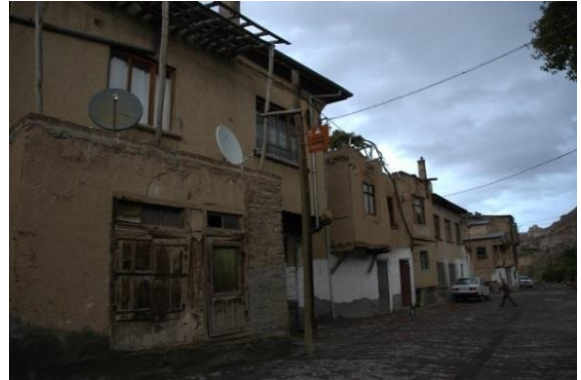
Şekil 7. Yığma sistemle yapılmış toprak yapılar: Şanlıurfa/Harran; Konya/Sille(Özen, Fotoğraf Arşivi)
