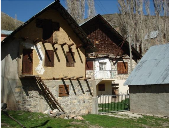
Şekil 38. Toprak malzemenin yapıda kullanımı (Alaca Köyü; Şalcılar Köyü)
