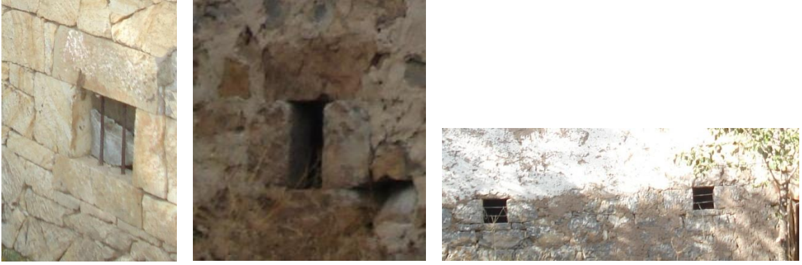
Şekil 53. Zemin kat(ahır) pencereleri
