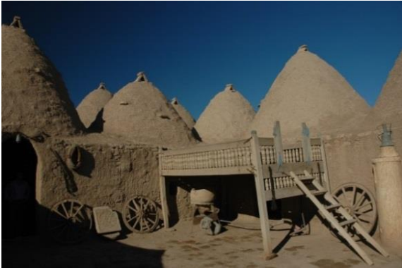
Şekil 7. Yığma sistemle yapılmış toprak yapılar: Şanlıurfa/Harran; Konya/Sille(Özen, Fotoğraf Arşivi)
