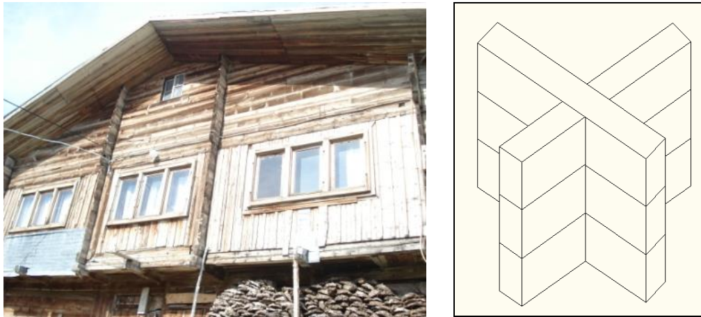
Şekil 39. Bayburt/Aydıntepe/Dumlu köyü çatma duvar
