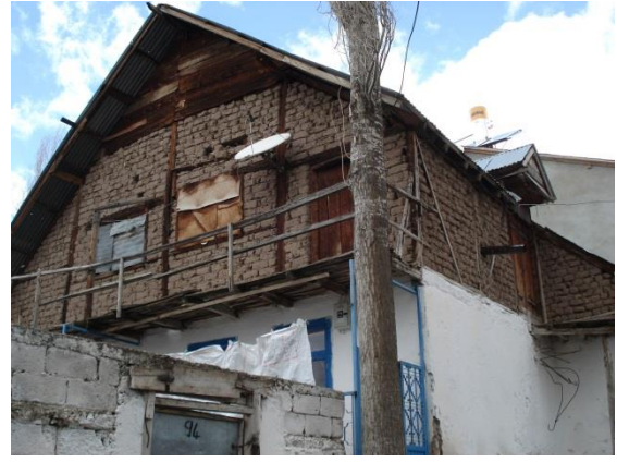
Şekil 38. Toprak malzemenin yapıda kullanımı (Alaca Köyü; Şalcılar Köyü)
