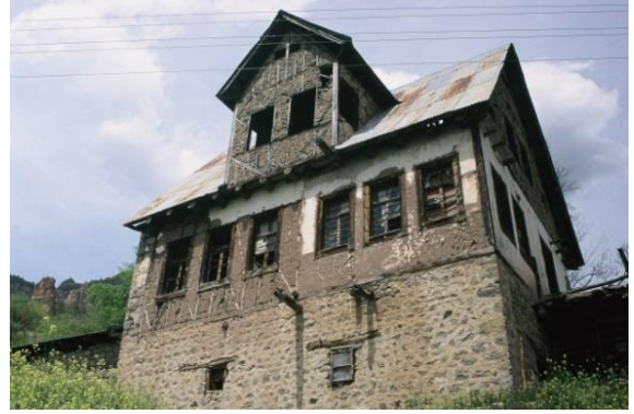
Şekil 8. Toprağın yapı malzemesi olarak kullanılması: Ankara/Hamamönü; Gümüşhane (Özen, Fotoğraf Arşivi)
