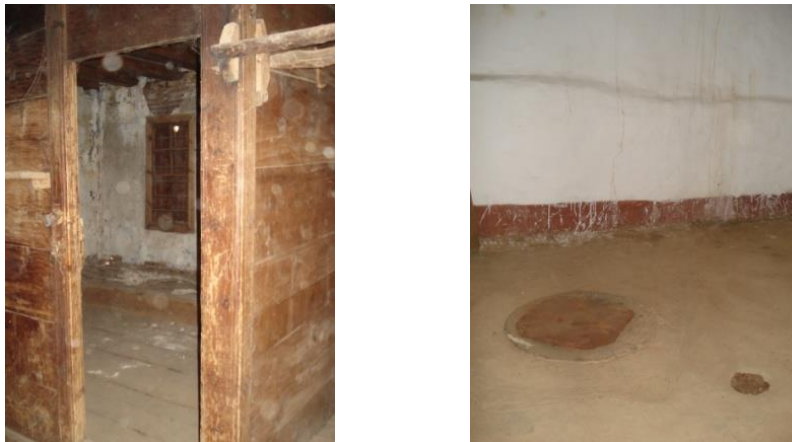
Şekil 45. Ahşap ve toprak zemin kullanımı (Başpınar Köyü, Sorkunlu Köyü)
