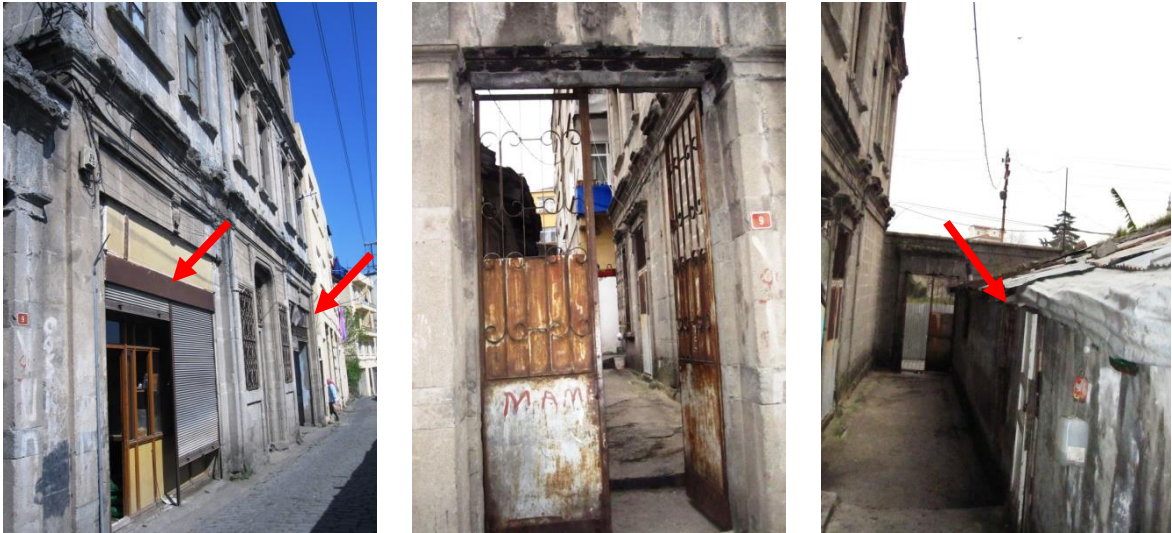
Şekil 2.11. Z03 nolu odanın muhdes cephesi(solda), bahçeye açılan taç kapı (ortada) bahçede bulunan muhdes yapılar (sağda)
