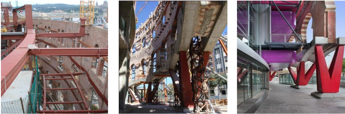
Şekil 1.25. Yapıya uygulanan müdahalelerden görüntüler, (URL-22 )
