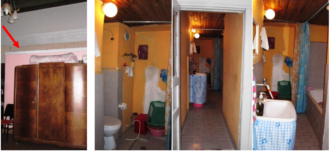
Şekil 2.18. 207 nolu oda içindeki muhdes yapı (solda), bu muhdes yapı içinde işlevlendirilen banyo-tuvalet birimleri (sağda)
