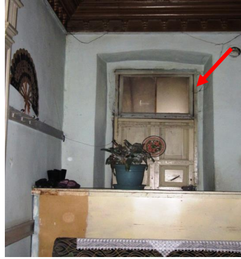
Şekil 2.13. Birinci katta kapıya çevrilen pencere
