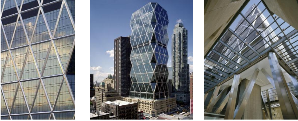
Şekil 1.17. Ek yapının cephesinden (solda ve ortada) ve binanın girişinden görüşler (sağda), (URL-18)
