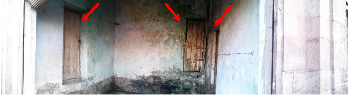
Şekil 2.10. Z04 nolu mekandaki muhdes kapılar
