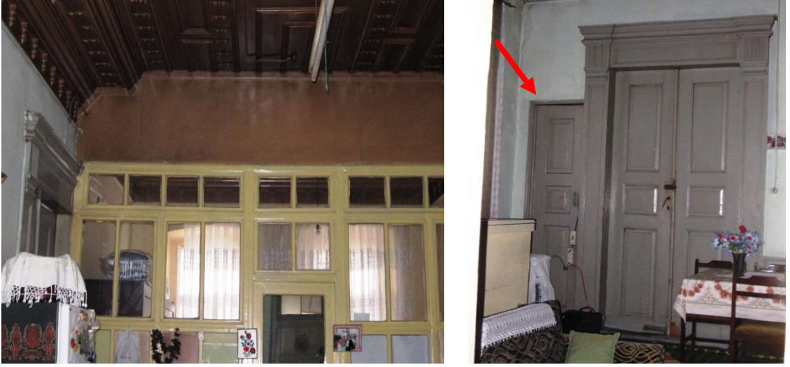
Şekil 2.14. Bölücü panellerle oluşturulan 105 nolu odadan ( solda) ve birinci kata açılan muhdes kapıdan (sağda) görüşler
