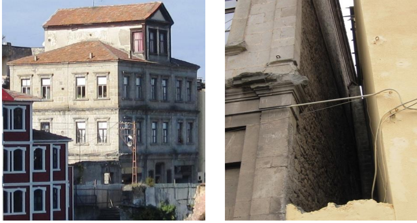
Şekil 2.24. Güney-batı cephesi ile sađır olan kuzey cephesinden görünüşler
