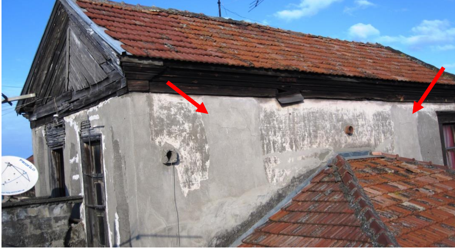
Şekil 2.22. Çatı katının güney cephesine ait kapatılan pencereler
