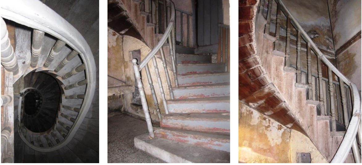
Şekil 2.8. Yapının merdiveninden görüşler
