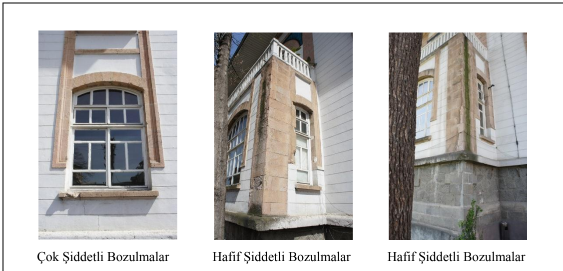
Őekil 17. Kltr ve Turizm Mdrlę binası bozulmaları
