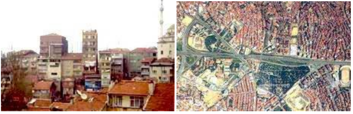
Şekil 12. Kuştepe kentsel dönüşüm projesi (URL-12, 2012)
