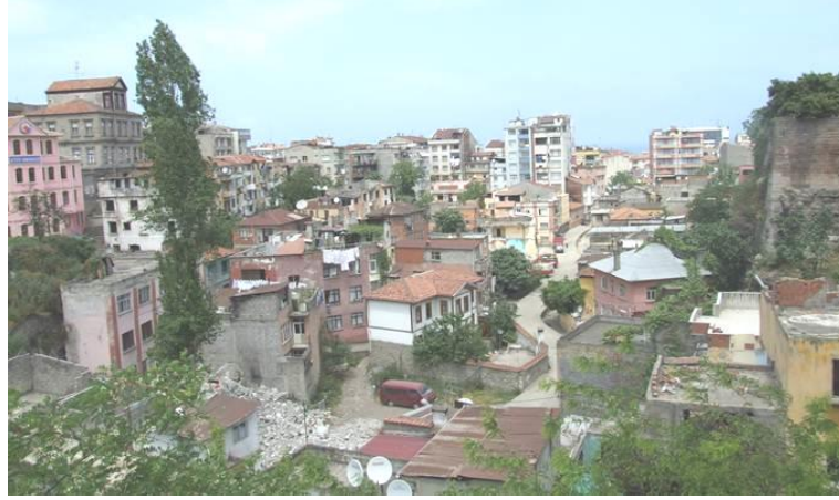
Şekil 15. Zağnos Vadisi 3. etap kentsel dönüşüm çalışması öncesi
