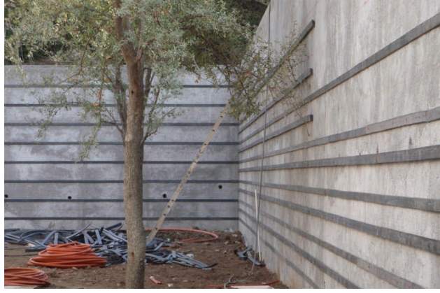
Şekil 18. Taşıyıcı sistemde kullanılan ve geri dönüşümlü olan polietilen profiller (25)
