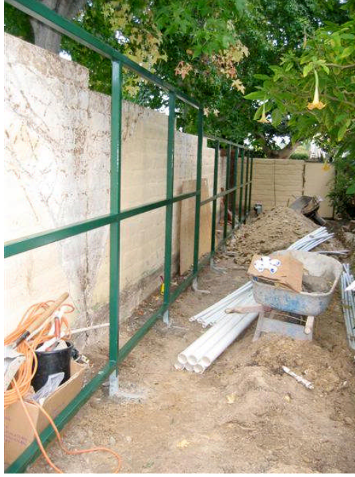
Şekil 35. Serbest bir bitkilendirilmiş hasır duvarın alt yapısı/boyanmış çelik malzemeli taşıyıcı sistem (27).
