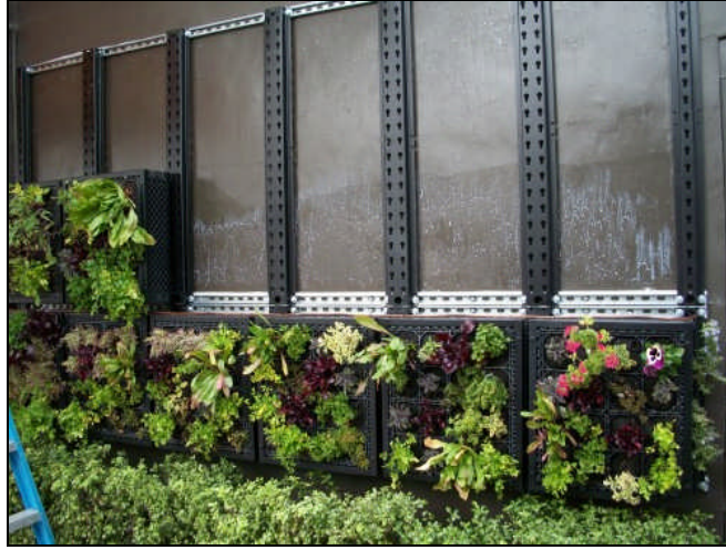
Şekil 19. Taşıyıcı sistemde kullanılan çelik malzeme (26)
