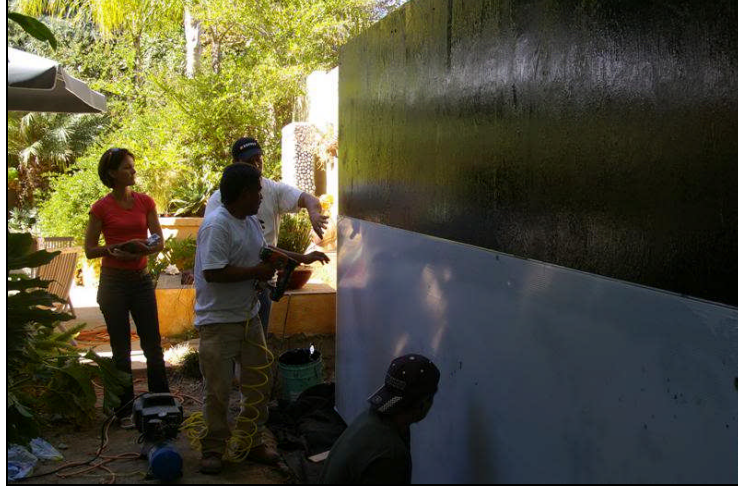
Şekil 37. Bitkilendirilmiş hasır duvarlarda kullanılan PVC destek katmanı (27)
