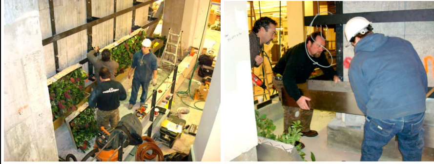
Uygulamadan Görünüm Uygulamadan (Su Tutma Kanalı) Görünüm GLT Paneller İle Uygulama
