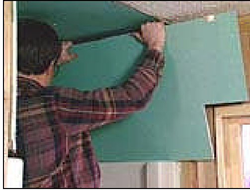
Şekil 15. Nem yalıtım malzemesi (Greenboard) (21)
