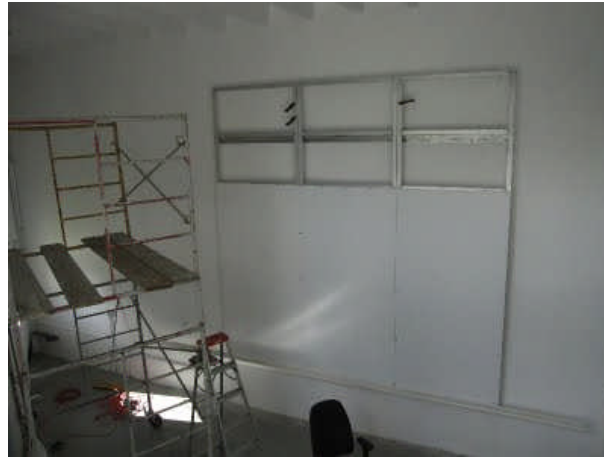
Şekil 38. Alüminyum alt yapı üzerine doğrudan uygulanan PVC destek levhaları (27)
