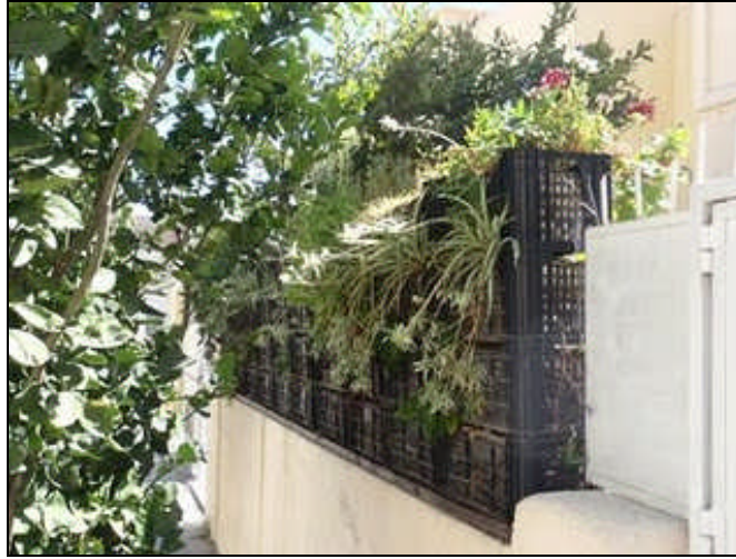
Şekil 27. Modüler bir dikey yeşil sistem oluşturan plastik malzemeden üretilmiş bir modül örneği (27)
