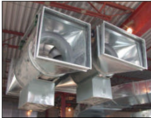
Şekil 51. Dönüş fanları örneği (45)
