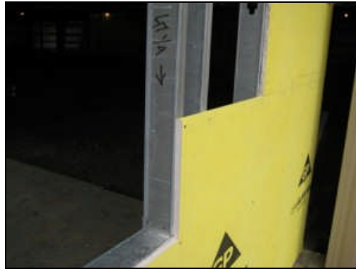
Şekil 16. Nem yalıtım malzemesi (densglass) (22)
