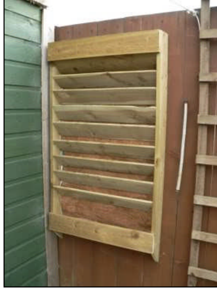
Şekil 20. Ahşap taşıyıcı sistem ve büyüme ortamı örneği (27)
