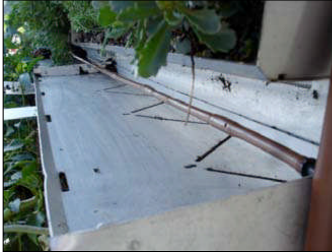
Şekil 64. Damla sulama sisteminin modüler yaşayan duvar uygulamasında kullanımı örneği (58)
