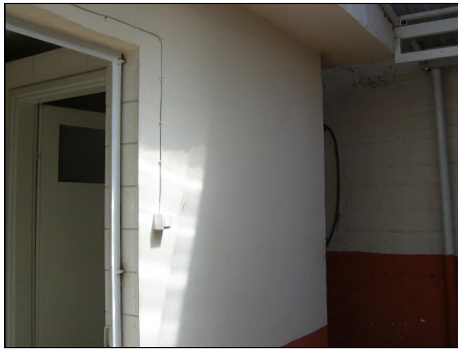
Şekil 100. Örnek uygulama için seçilen duvar
