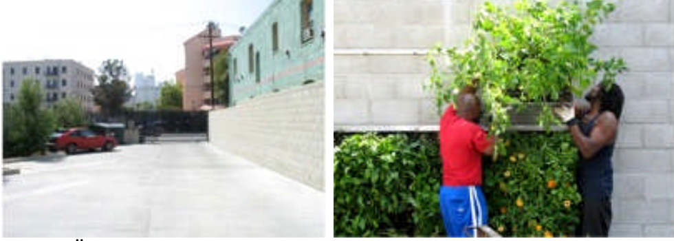
Uygulamadan Önce Uygulamadan (Taşıyıcılar ve Sulama) Görünüm GLT Paneller İle Uygulama
