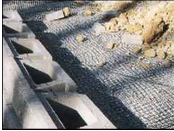
Şekil 56. Jeogrid malzemenin kullanım örneği (50)
