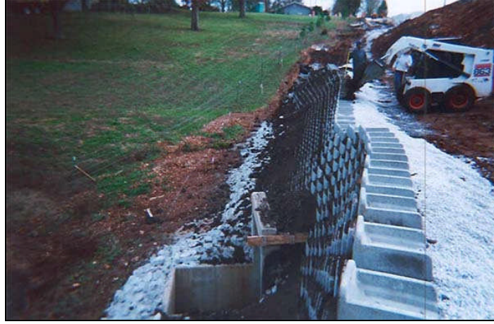
Şekil 57. Kazı sınırı arka kısım dolgu malzemesi ve büyüme ortamına araçla doldurulan bitki tutucu tabaka (47)
