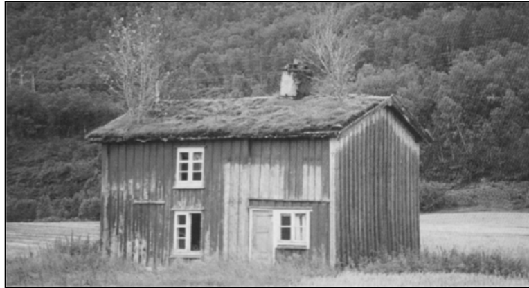
Şekil 10. Norveç’te yüzyıllar önce çatısı çimle kaplanmış ve üzerinde bir ağaç yetişmeye başlamış, halen ayakta olan küçük bir ev [26]
