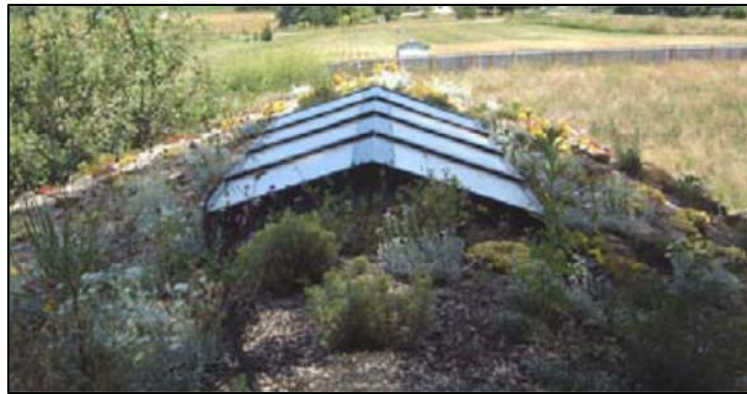
Şekil 26. Yeşil çatı ve güneş panelleri
