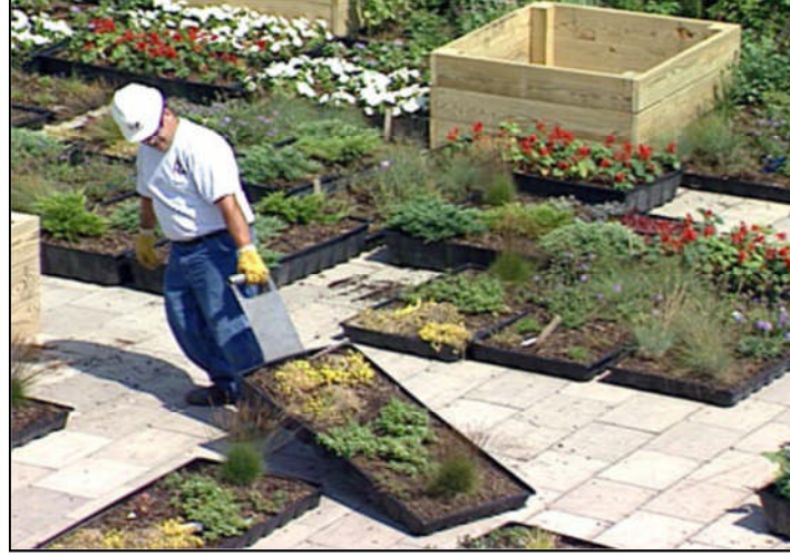
Şekil 30. Modüler elemanlarla yeşil çatı uygulaması
