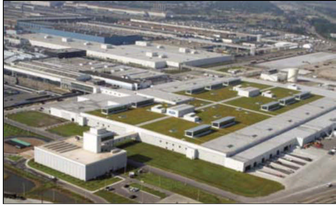
Şekil 29. Ford fabrika binası, Michigan, W. Mc Donough
