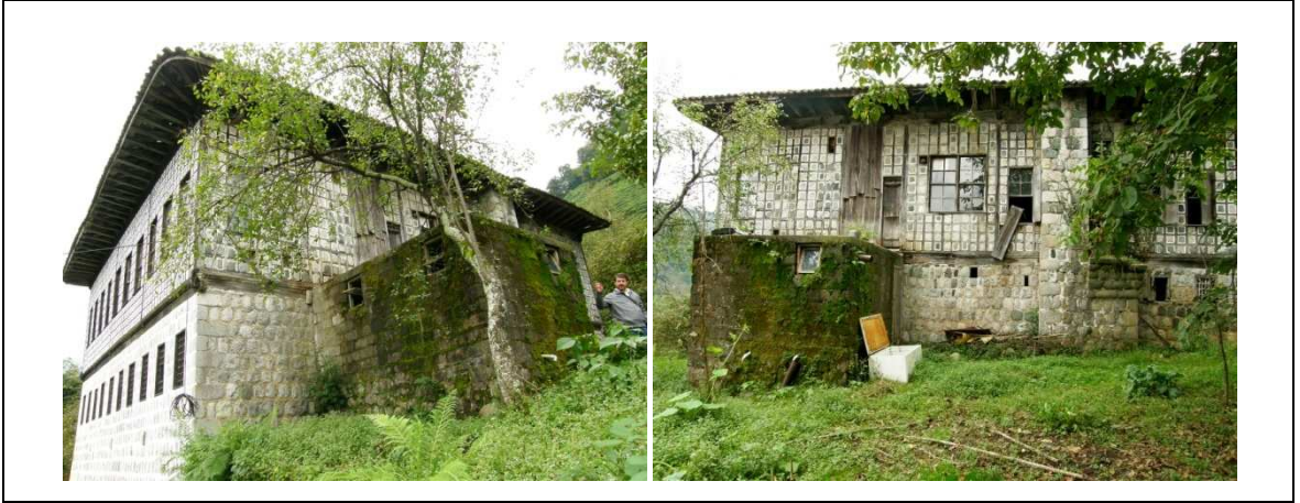
Şekil 87. Konağın kuzey cephesini kapatan ağaçlar.
