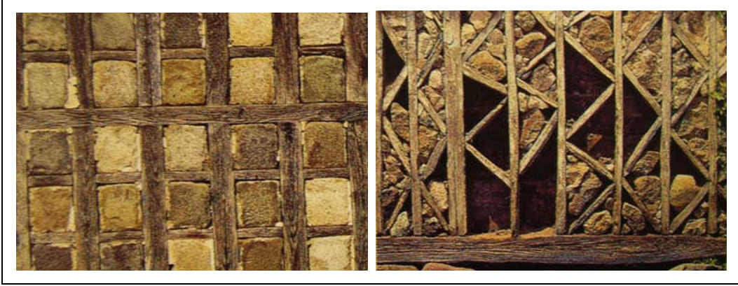
Şekil 10. Göz dolma ve muskalı dolma tekniği [19].
