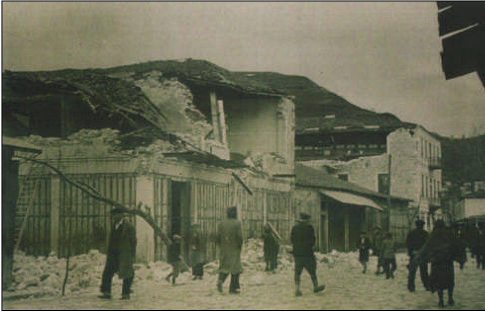
Şekil 2.1939 Erzincan depremi sonrası Ordu'daki hasar görüntüleri [4]
