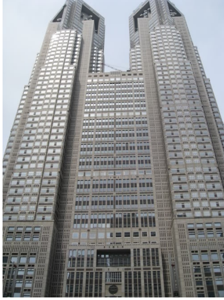
Şekil 19. Tokyo Belediye Binası, Kenzo Tange, Tokyo, 1991
