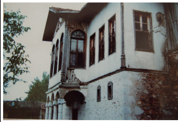
güney cephe görünüşü
