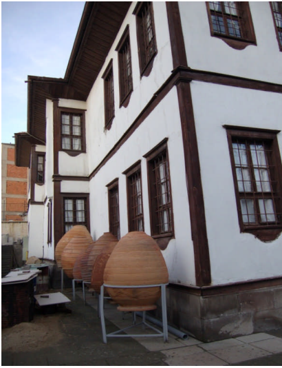
nizamoğlu güneybatı cephe görünüşü
