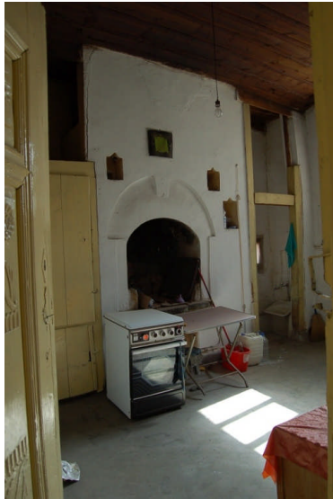
1.kat mutfak taş ocak görünüşü
