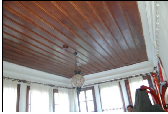
zemin kat güneydoğu oda tavan görünüşü
