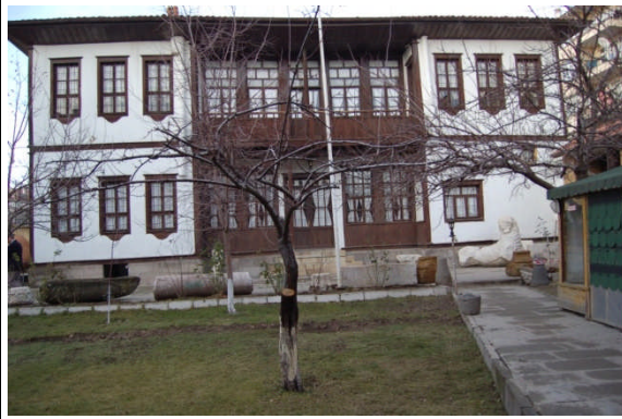
güney cephe görünüşü
