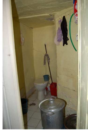
zemin kat güneybatı odası gusulhane görünüşü
