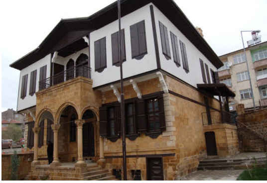
güneydoğu giriş ve kuzeycephe giriş kapısı görünüşü
