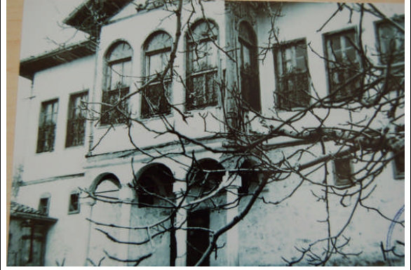
güney cephe görünüşü
