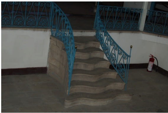
kuzey cepheden iniş merdiveni
