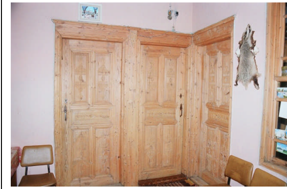
1.kat sofadan kapı detayı görünüşü1
