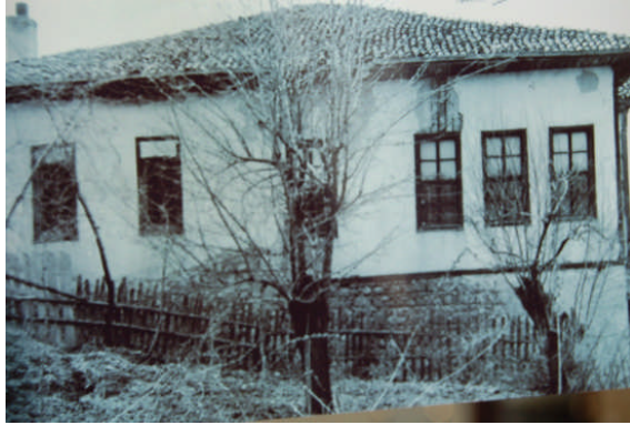
dış cephe görünüşü
