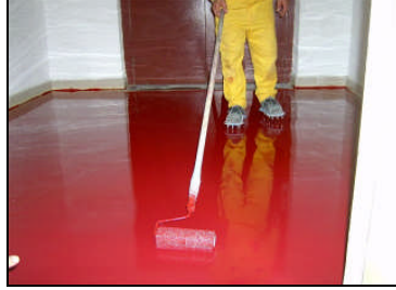
Şekil 97. Likit yalıtım malzemesi uygulaması
