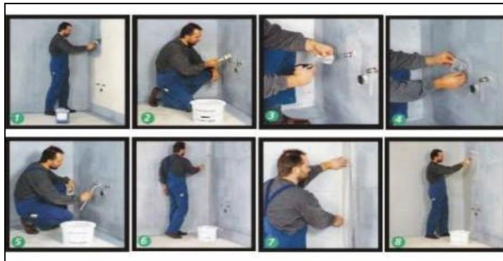
Şekil 77. Islak hacimde su yalıtım uygulaması
