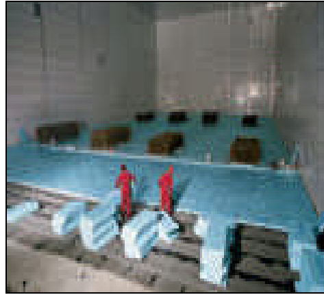
Şekil 80. Soğuk hava deposunda ısı yalıtımını uygulaması
