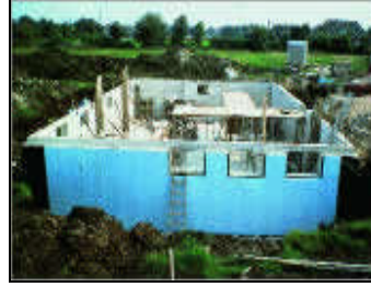
Şekil 74. Perde duvarda ısı yalıtımı
