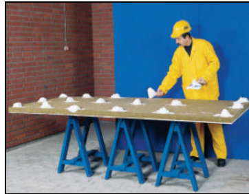
Şekil 93. Noktasal yapıştırma
