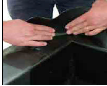
Şekil 95. Ek yerlerinin kendinden yapışkanlı PVC bantla yapıştırılması
