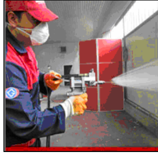
Şekil 62. Poliüretan köpük uygulaması
