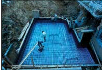
Şekil 76. Döşeme altında ısı ve su yalıtım uygulaması
