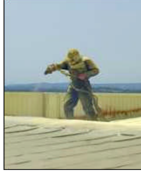
Şekil 28. Poliüretan sert köpük uygulama [40].
