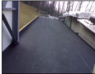
Şekil 83. Su yalıtımı uygulaması
