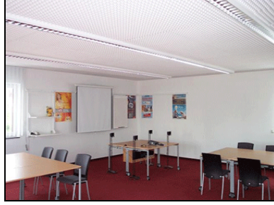
Şekil 82. Ses yalıtımı uygulaması
