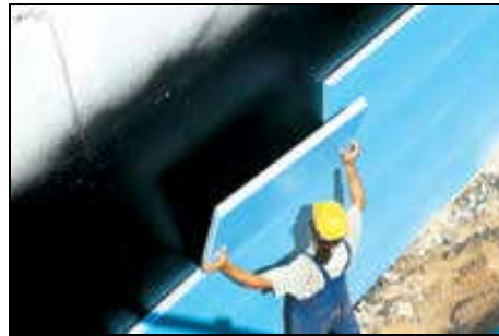
Şekil 23. Genleştirilmiş polistiren köpük ile temel duvarı yalıtımı [13]
