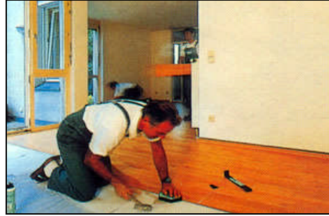
Şekil 35. Polietilen levhaların döşeme kaplama malzemesi ile uygulanması [42]
