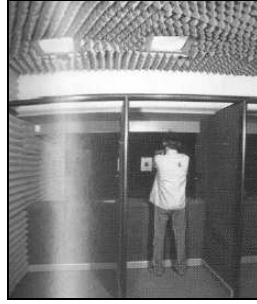
Şekil 9. Yüksek düzeyde ses emicili sağlanmış silah atış odası [4]
