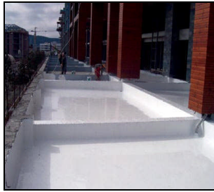
Şekil 65. Poliüretan likit yalıtım uygulaması
