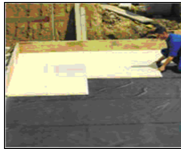
Şekil 48. Temel yalıtımında mekanik sabitleme yapılmış PVC örtü [51]
