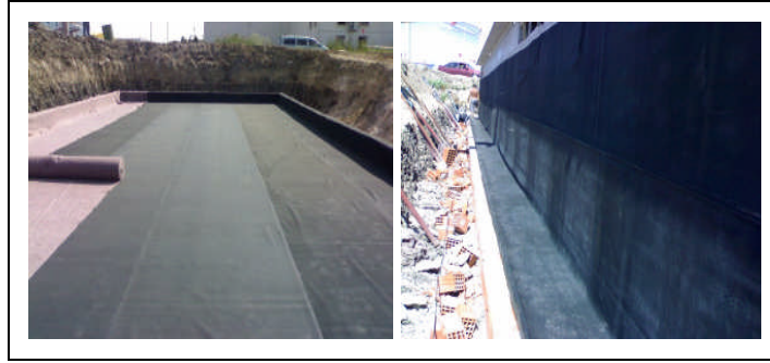
Şekil 50. EPDM örtü uygulamaları [48]
