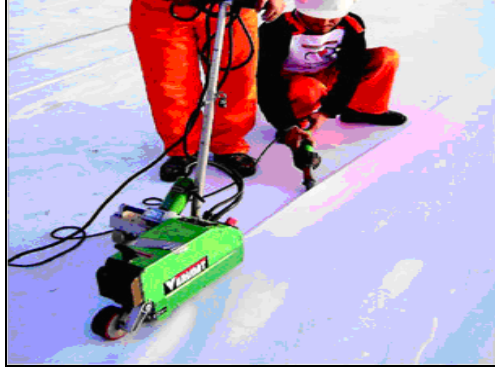
Şekil 90. Örtü bini yerlerinin kaynak makinesiyle yapıştırılması
