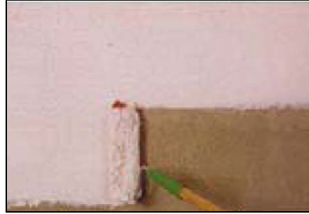
Şekil 44. Poliüretan esaslı su yalıtım malzeme uygulaması [45]
