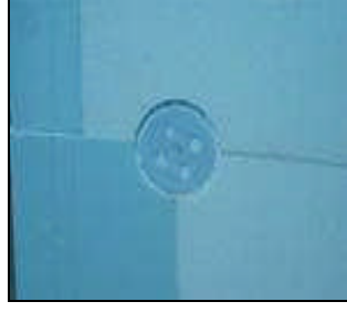
Şekil 96. Isı yalıtım malzemesinin dübelle mekanik sabitlenmesi
