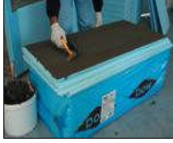
Şekil 94. Yüzeysel yapıştırma
