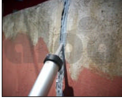
Şekil 66. Mastikle derz dolgu uygulaması
