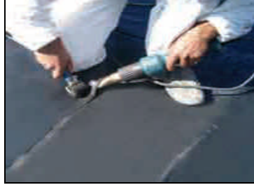
Şekil 98. Kaynakla su yalıtım örtüsünün yapıştırılması
