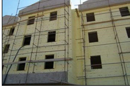
Şekil 81. Isı yalıtımı uygulaması
