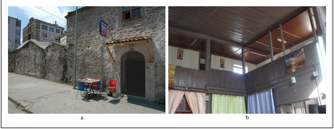
Şekil 32. a. Yukarı Hamam doğu cephesi, b. hamam iç mekanı
