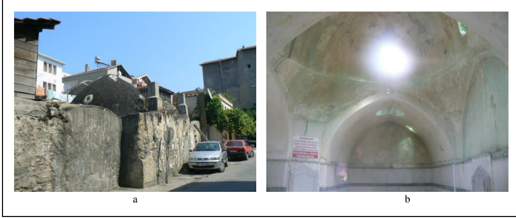
Şekil 48. a. Aşağı Hamam güney cephesi b. hamam iç mekanı
