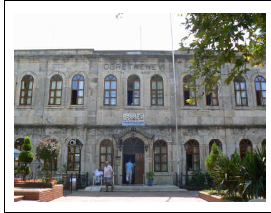
Şekil 65. Öğretmenevi kuzey cephesi
