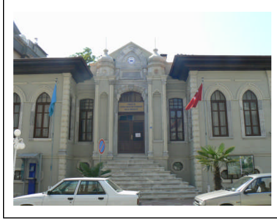
Şekil 62. PTT binası kuzey cephesi
