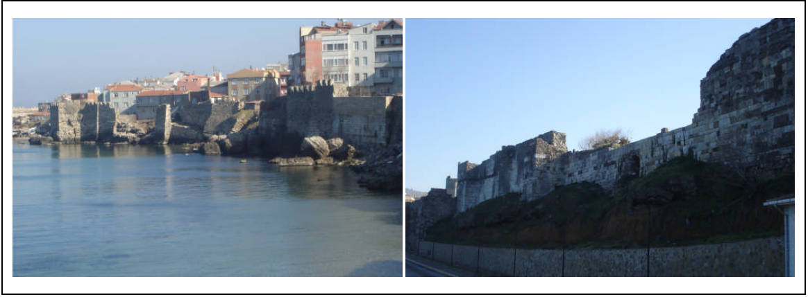
Şekil 9. Dış kale kuzey surları
