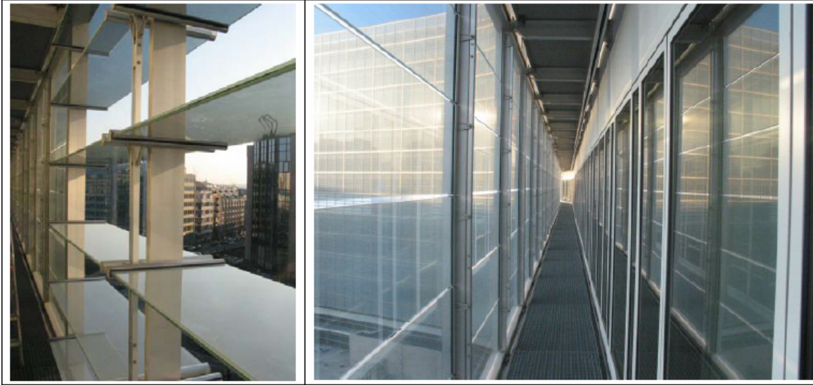
Şekil 48. Jalûzilerin cephedeki yatay ve dikey pozisyonundaki görünüşleri ( BBRI, 2002).
