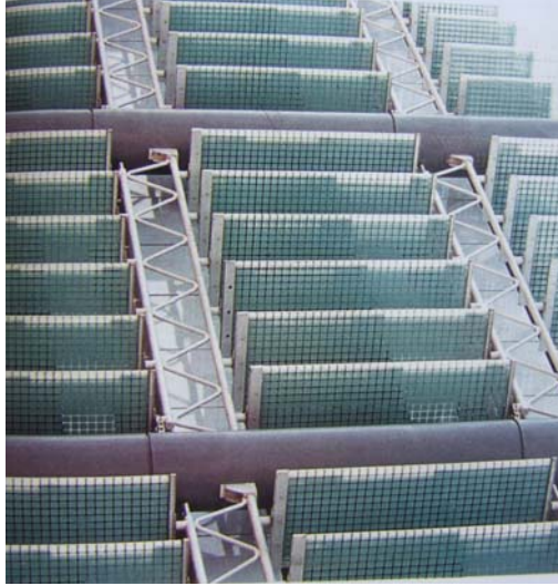
Şekil 39. Fotovoltaik cephe örneği (Eşsiz ve Özgen, 2004)
