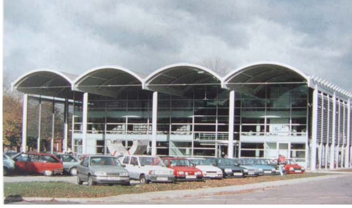
Şekil 26. Cranfield teknoloji enstitüsü kütüphane binası, saçaklı çatı, İngiltere (Compagno,2002).
