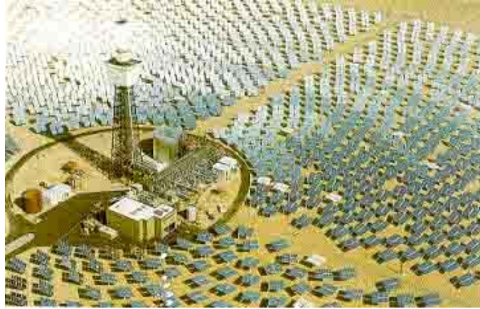
Şekil 13. Merkezi alıcılı güneş ısıl elektrik santrali
