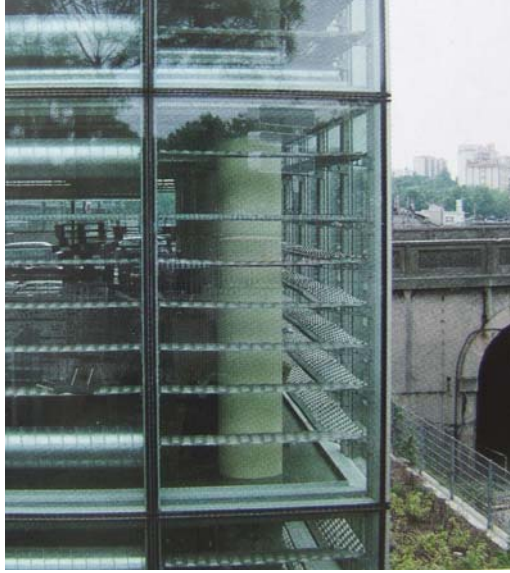
Şekil 32. Hôtel industriel Jean- Baptiste Berlier binası, iç mekânda görünen yatay güneş kontrol üniteleri, Paris
