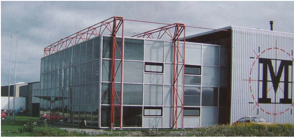
Şekil 31. Mors binası, Hollanda, 1998 (Compagno, 2002).
