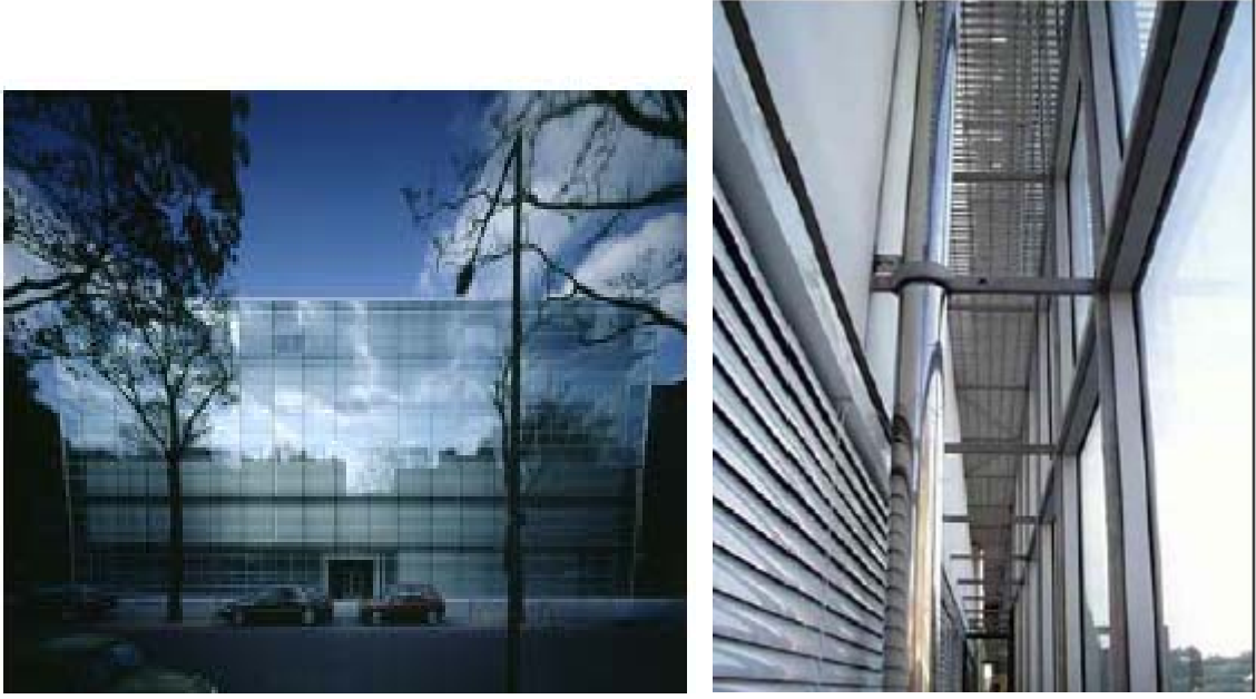
Şekil 46. Victoria Ensemble binası ve çift kabuklu bina yüksekliğinde cephe kuruluşu (BBRI, 2002).
