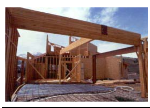
Şekil 20. Garage giriş kapısı (16)
