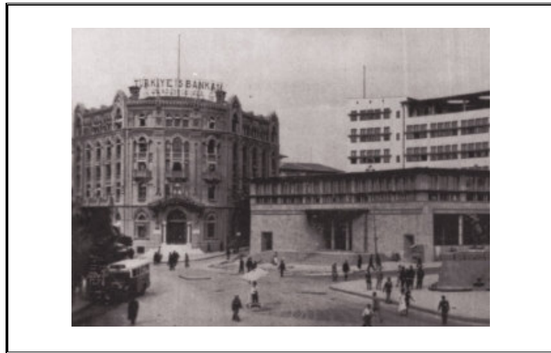
Şekil 38. Türkiye İş Bankası Merkez Binası, Giulio Mongeri, Ankara, 1929
