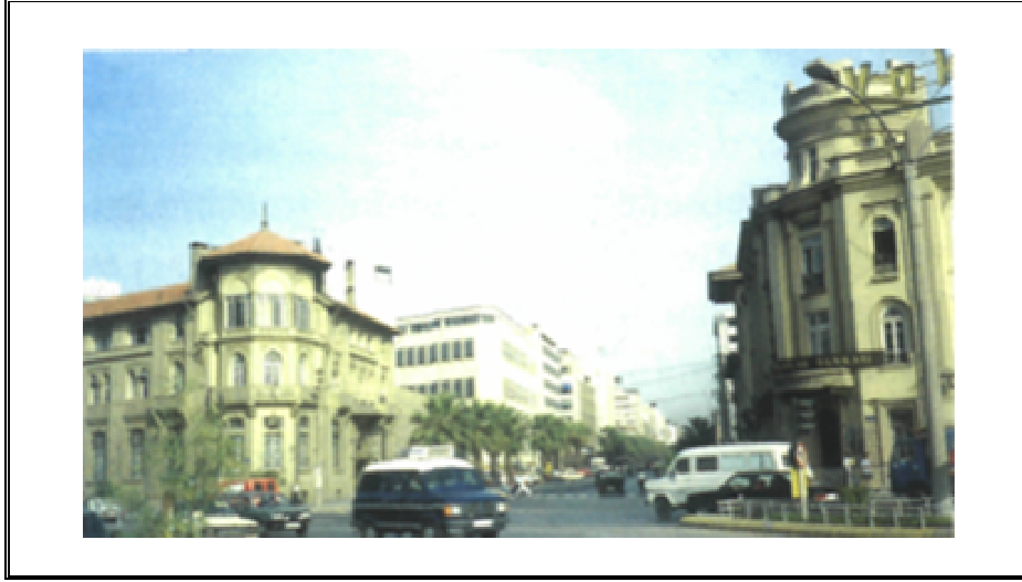
Şekil 11. Osmanlı Bankası (1926) ve Eski Vakıflar Bankası (1930), İzmir
