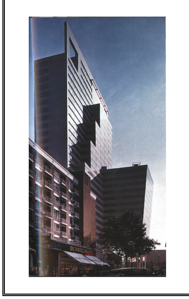
Şekil 72. General Bank Tower, Murphy /Jahn ve Yardımcı Mimarlar, Rotterdam,1996
