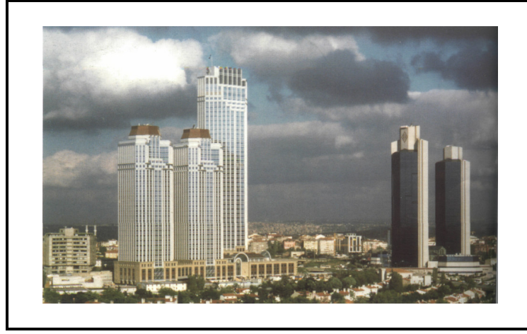
Şekil 44. İş Bankası ve Akbank kuleleri, İstanbul
