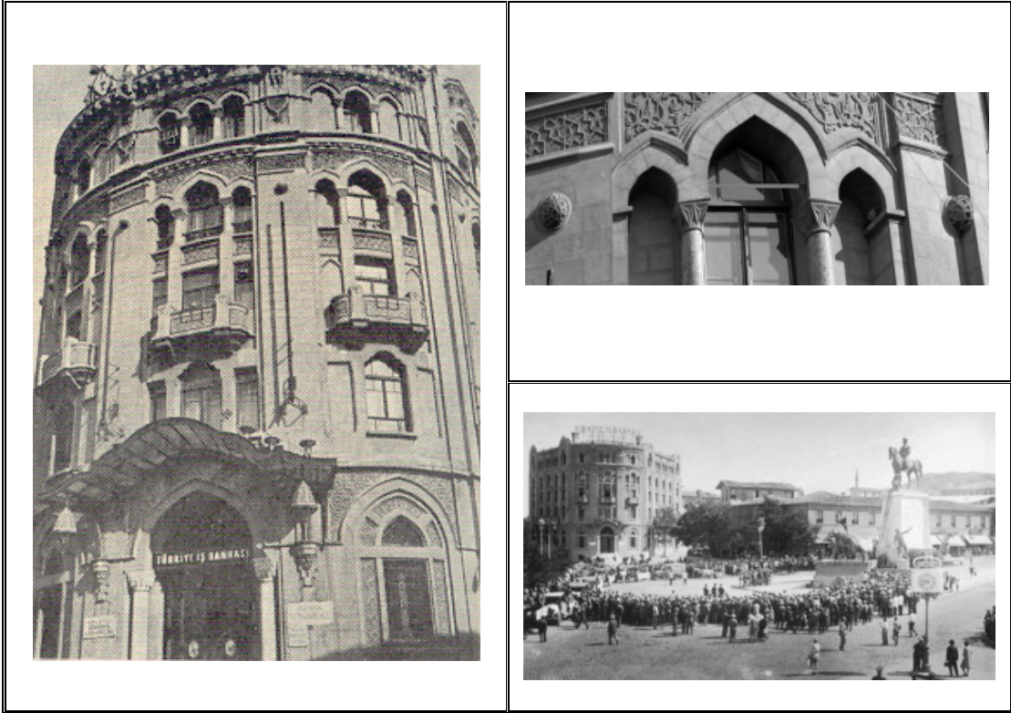
Şekil 13. Türkiye İş Bankası Merkez Binası, Giulio Mongeri, Ankara, 1929
