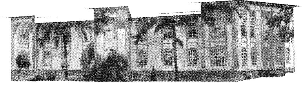
Şekil 49. Yakın resim fotogrametrisi çalışması sonucunda elde edilen fotomodel, (kuzeybatıdan bakış)
