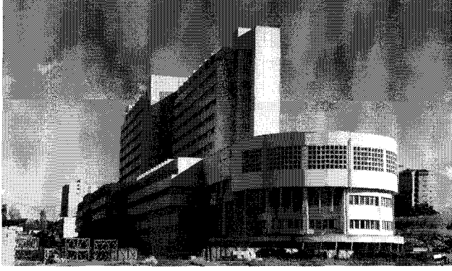
Şekil 80. Sayıştay Yeni Hizmet Binası, 2000, Ankara, mimar Ziya Tanalı
