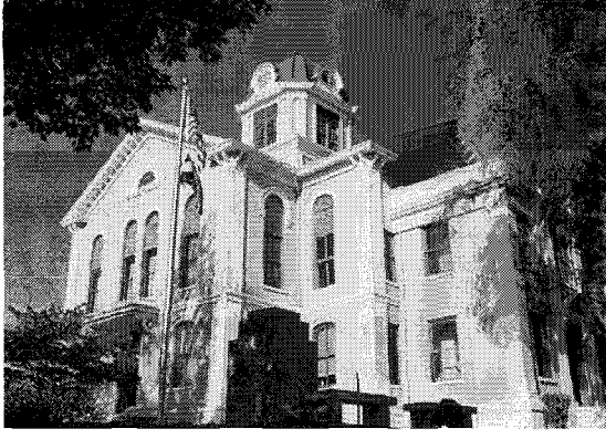
Şekil 44. Jefferson Jackson Kasabası Adliye Binası, 1879, mimar W.W. Thomas (URL-61, 2002).
