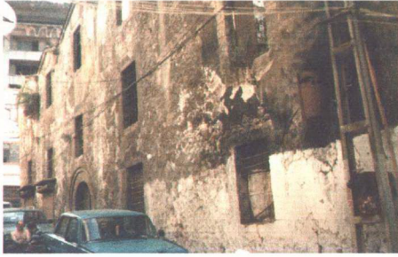
Şekil 40. Alacahan'ın doğu cephesinden görünüş
