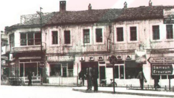
Şekil 27. Yakın dönemde yıkılan Suluhan'ın cadde görünüşü [52].
