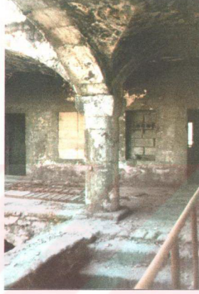
Şekil 75. Alacahan'ın 2.katındaki revak kemerlerini taşıyan daire kesitli kolon
