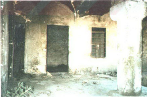
Şekil 76. Alacahan'da revağa açılan kapı ve pencereler
