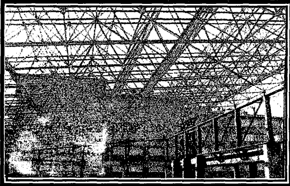
Ek Şekil 43. Tevfik Serdar Anadolu Lisesi Spor Salonu uzay kafes sistemi ve sistem özellikleri
