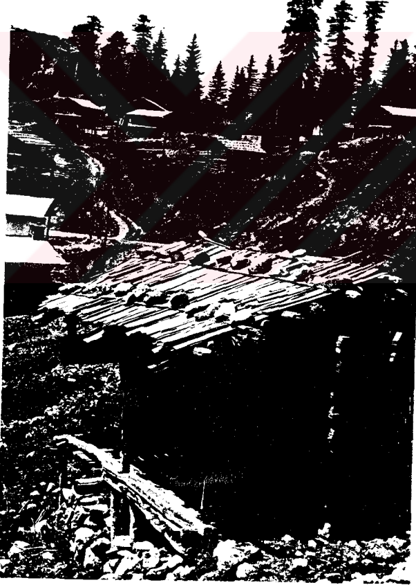
Şekil 49. Şavşat- Karaköy’de bedevra ile örtülü bir ev görünüşü
