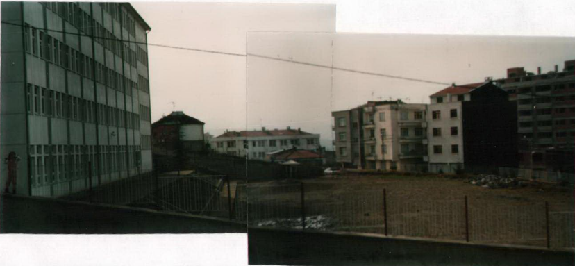
EK ŞEKİL 37: Yavuz Selim (Erdoğan) İlköğretim Okulu ve Arka Bahçesi
