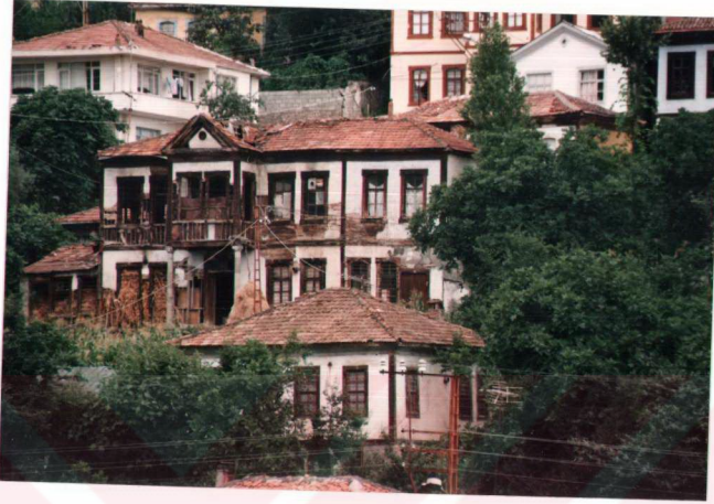
Şekil 28. Bakımsızlıktan yıkılmaya yüz tutmuş geleneksel bir ev.
