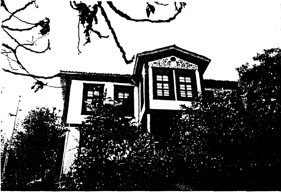
Şekil 85. Pencere kenarlarının ve üçgen alınlığın cephede vurgulanması.
