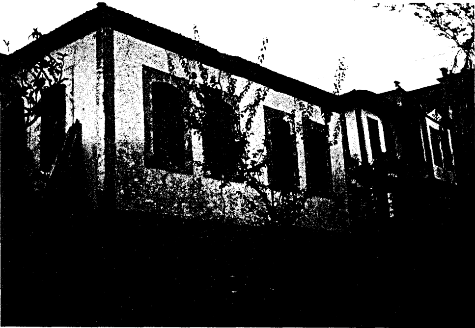
Şekil 75. Taş yığma sistemin kullanıldığı geleneksel konut
