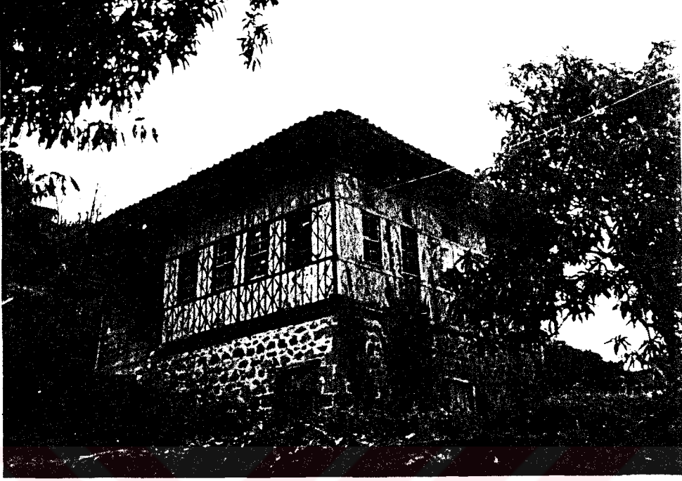
Şekil 37. Taş malzemenin ahır katında kullanılması
