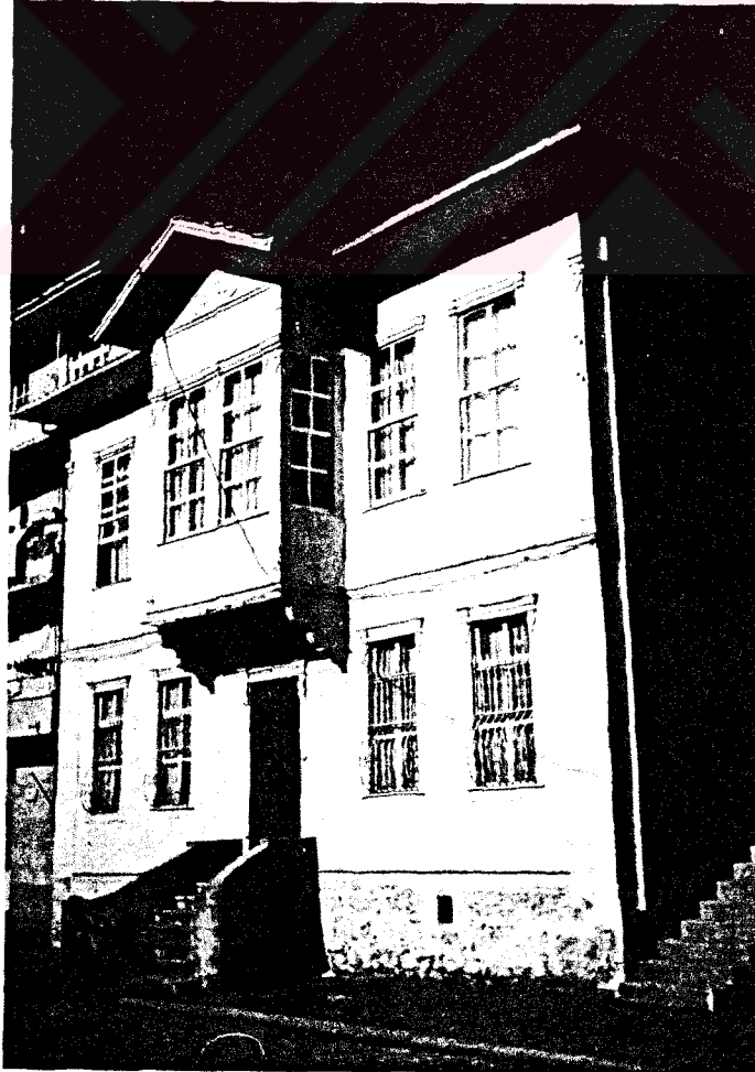
Şekil 54. Sıvalı cephe
