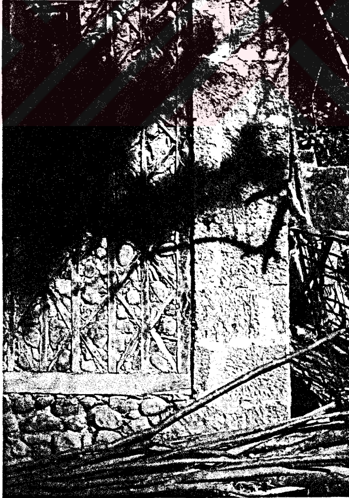
Şekil 38. Dolgu malzemesi olarak kullanılan taş
