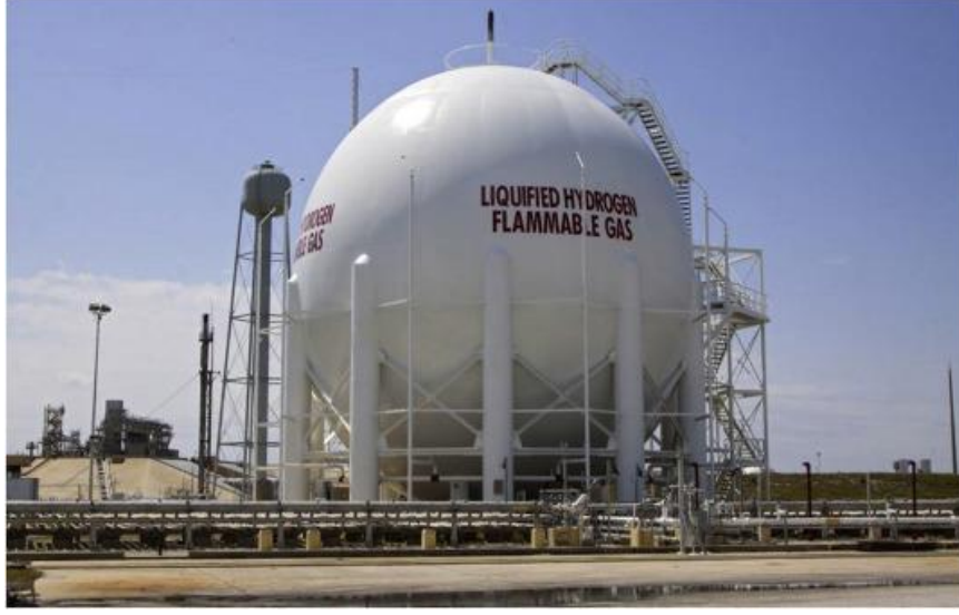
Şekil 15. Yaklaşık 224 ton sıvı hidrojen (LH 2 ) kapasiteli NASA'ya ait depolama tankı
