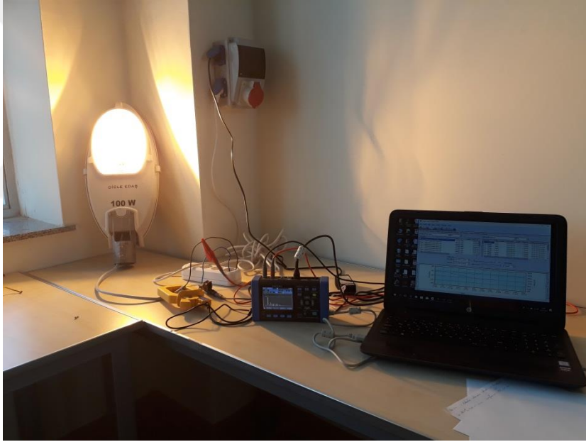
Şekil 69. Şebekeye 100W YBSB armatür bağlanması bağlantıları
