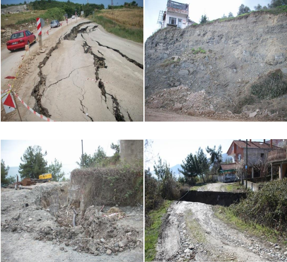
Şekil 45. Gerze ilçesi sahil yolu yapım çalışmaları sırasında meydana gelen hasara ait görüntüler
