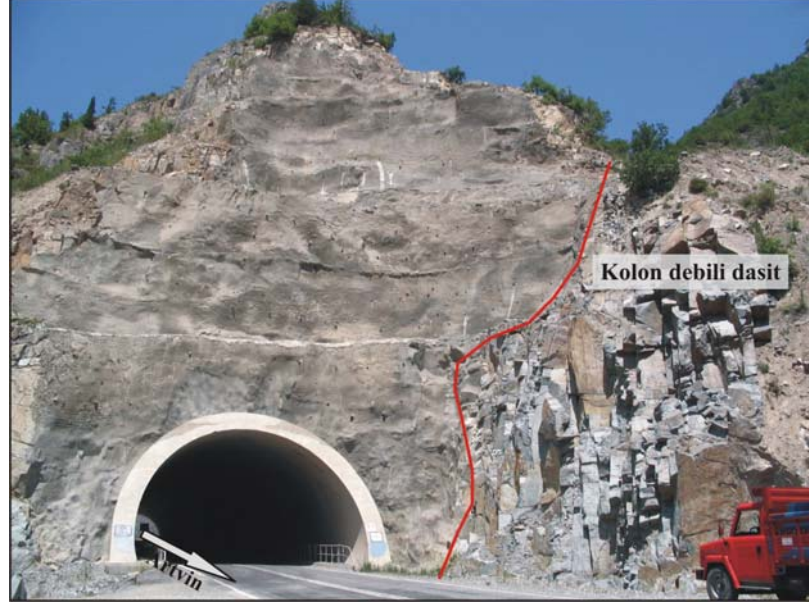
Şekil 3. 2. Erenler Mahallesi civarında Borçka-Artvin karayolu üzerinde gözlenen kolon debili dasitler
