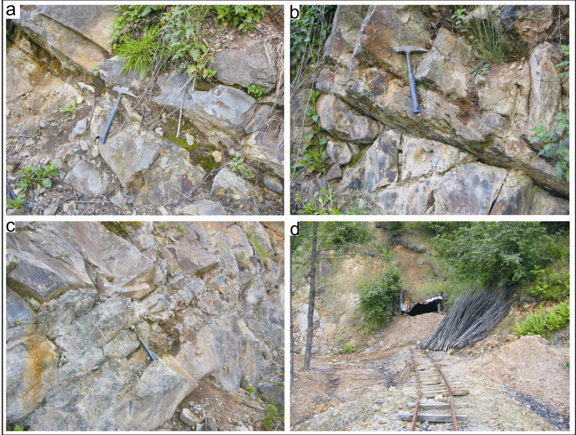
Şekil 28. a, b ve c) Madengözü deresinin kuzey yamacında bulunan cevher damarları, d)Ovaşkur deresi içindeki galerinin görünümü.
