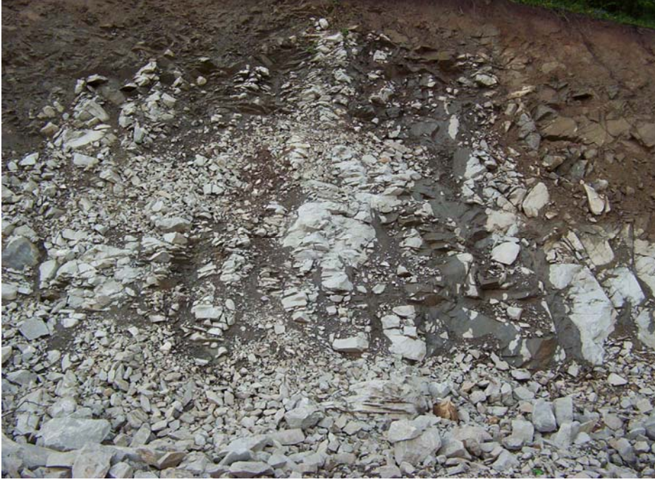
Şekil 3.23. Kalburcu Tepe Domu'nun kenar kısımlarında gözlenen bol çatlaklı ve kırıklı yapıya sahip otobreşlerin görünümü
