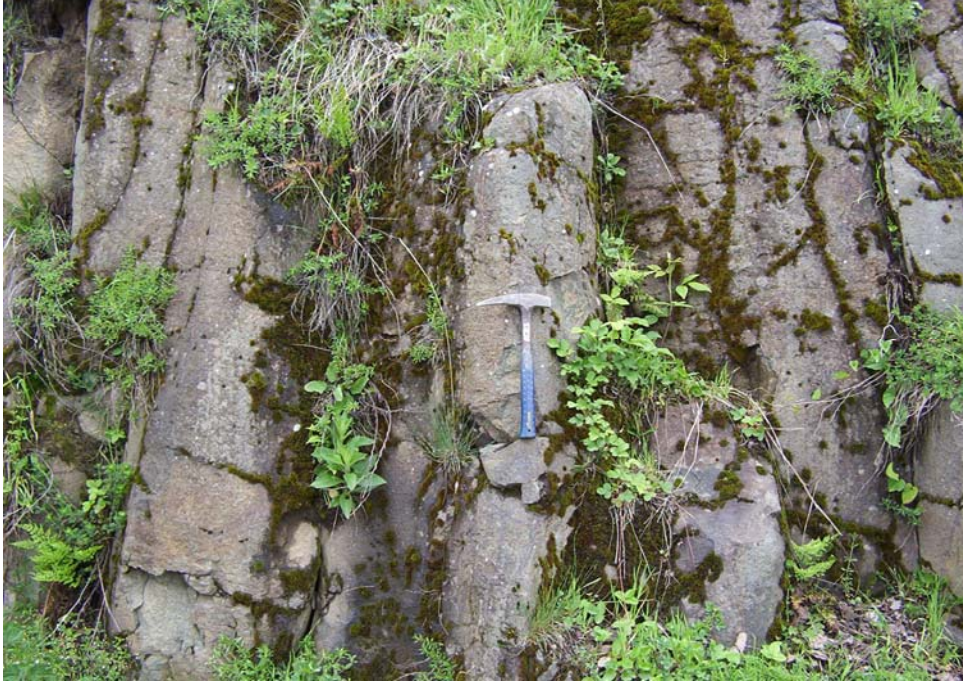
Şekil 3.7. Çöllen Mahallesi'nde yüzeylenen, bol kırıklı ve çatlaklı andezitlerin görünümü
