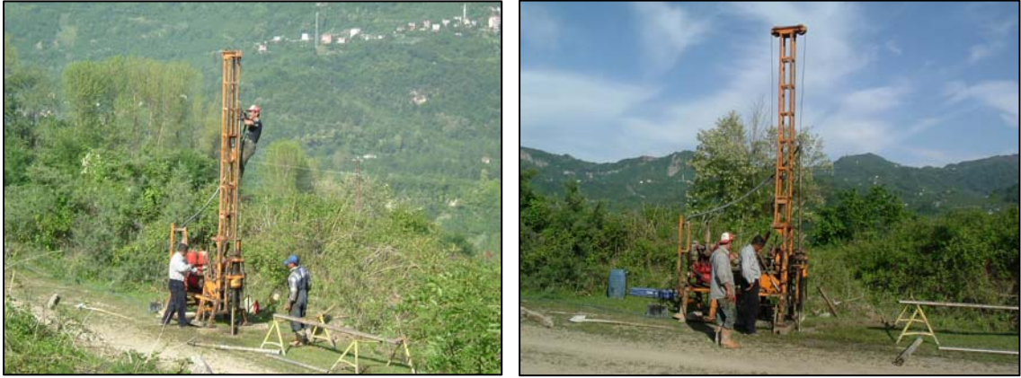
Şekil 3.27. Taş ocağının alt kotlarında açılan sondajlar (kot: 150 m)
