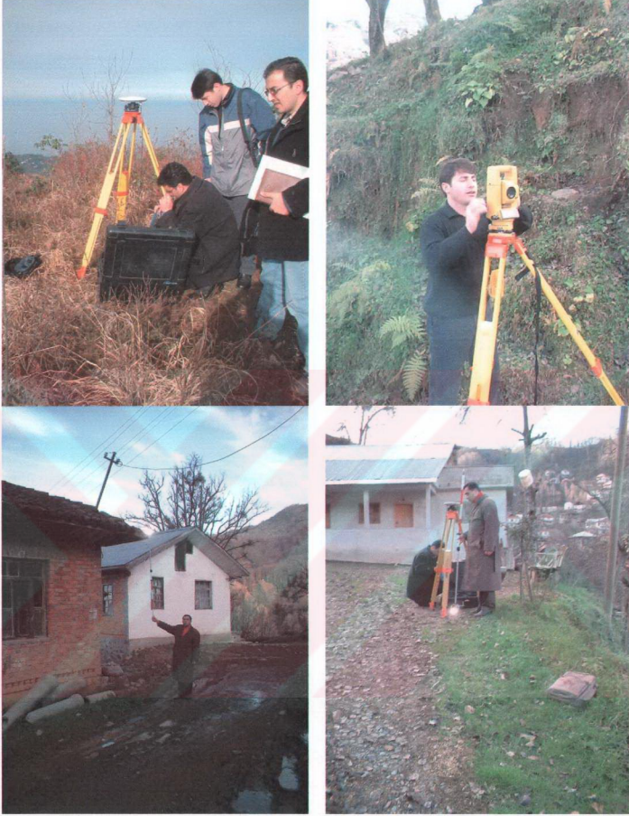
Şekil 30. Mutlak yönelme için gerekli olan detay noktalarının arazide ölçülmesi
