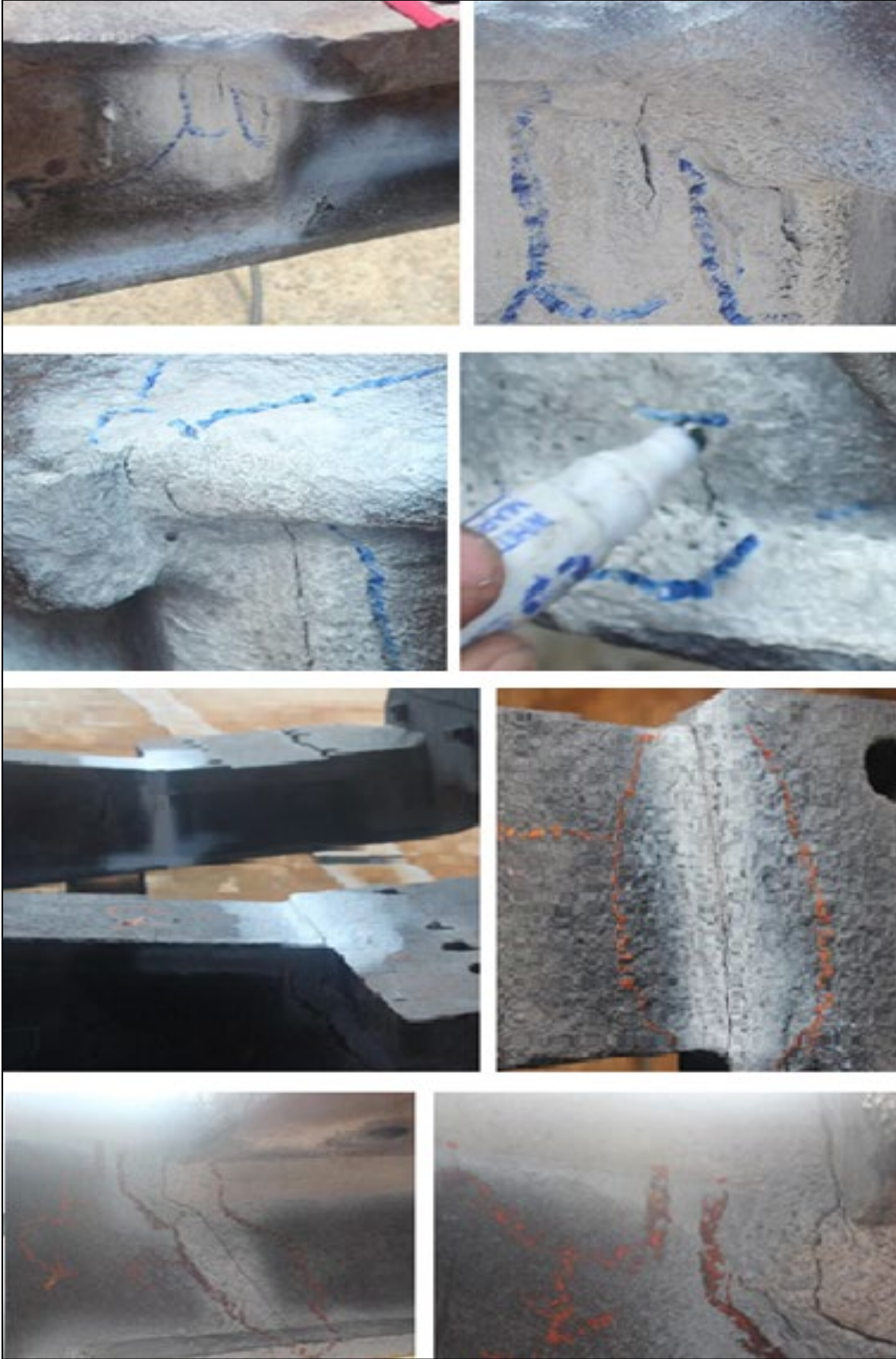
Şekil 95. Alt şasi arka ayaklarında görülen hasarlar
