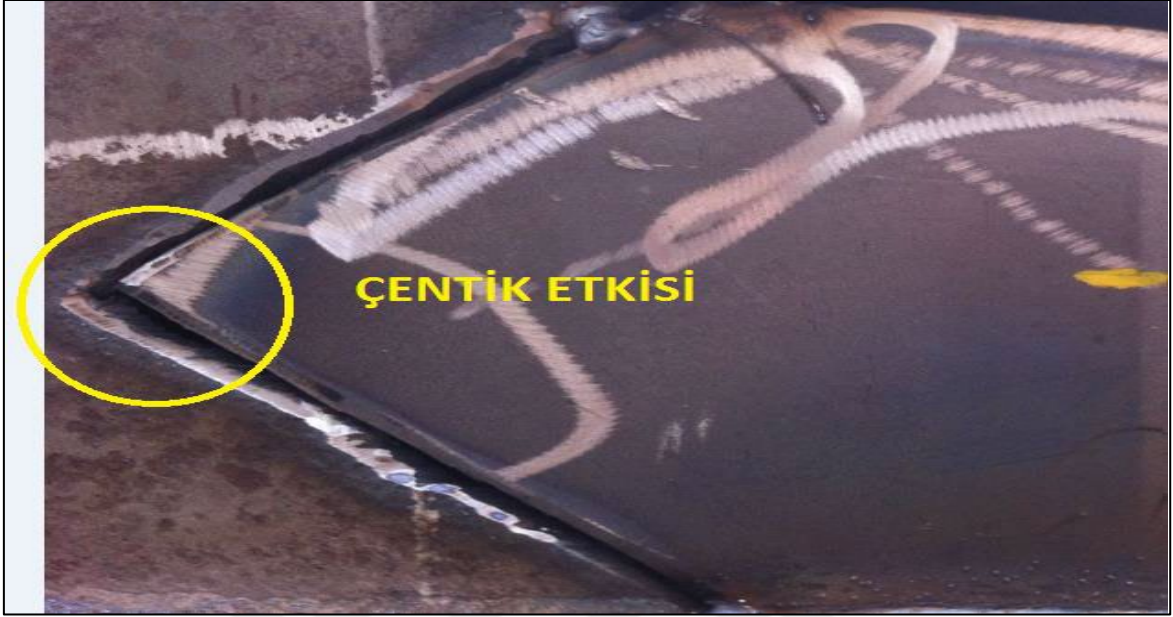
Şekil 66. Çentik etkisi oluşturabilecek tipik bir birleşim
