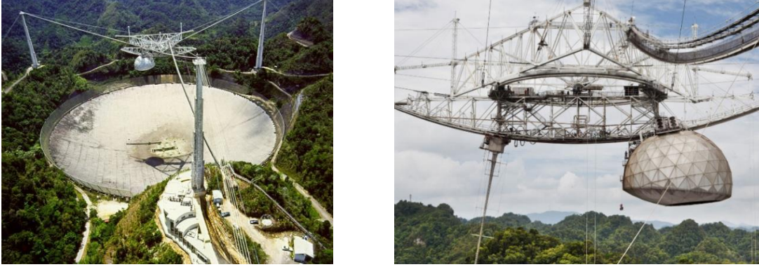
Şekil 5. a) Arecibo gözlemevi, Puerto Rico b) Alıcı kabin (Williams ve Robert, 2015)
