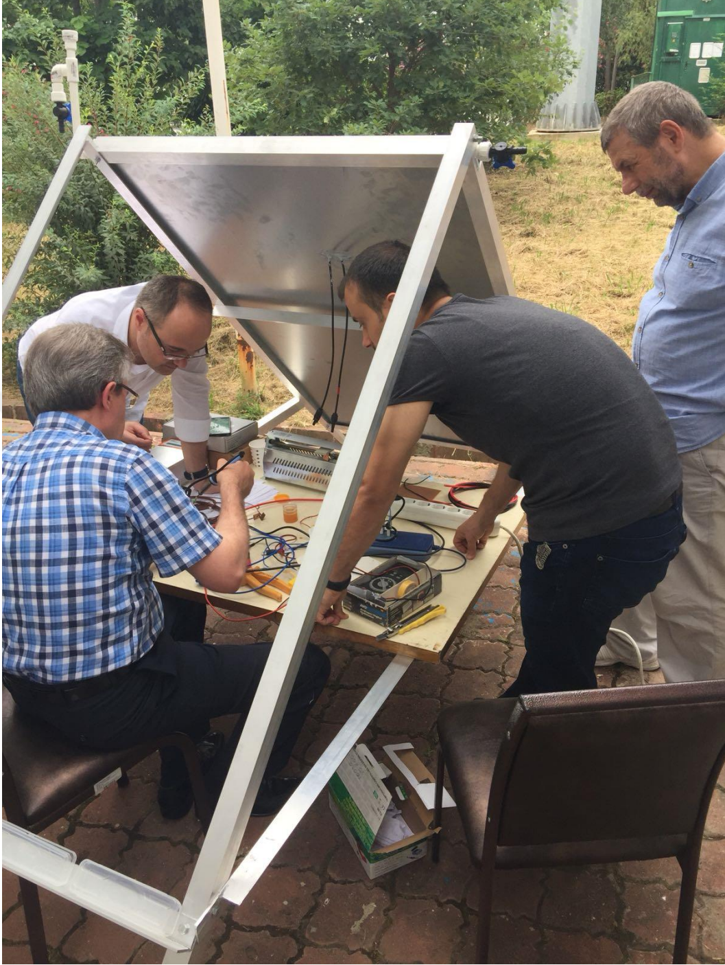
Ek Şekil 5. Sistemin kablo bağlantılarının yapılması
