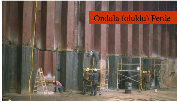
Şekil 1.32. Bir gemi ambarında ondüla perdenin onarım çalışması
