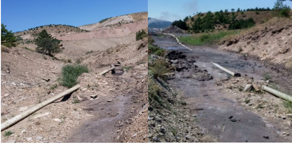
Şekil 1.25. Tunçbilek tikinerinden atık barajına giden boru hattı
