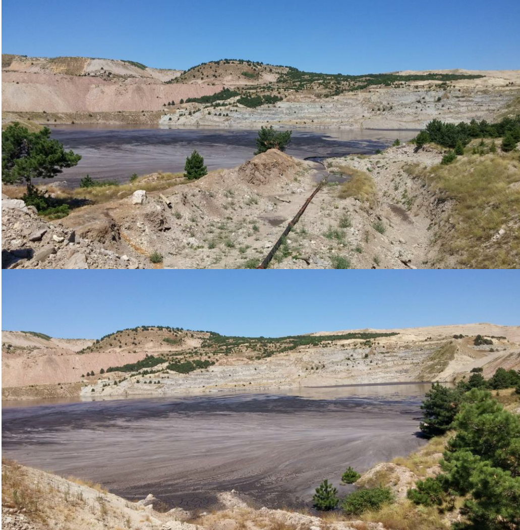
Şekil 1.26. Tunçbilek lavvar atık barajından görüntüler (Fotoğraflar: Tuncay USLU ve Özüm YAŞAR)
