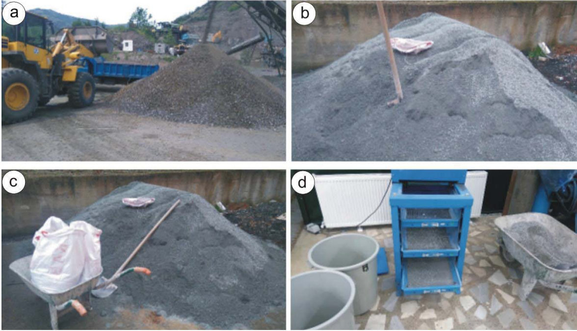
Şekil 2.6. Doğal agreganın kırma eleme tesisinden taşınması, a) Kamyonu yükleme, b, c, d) Paketleme ve uygun sınıf aralığına getirilme işlemi
