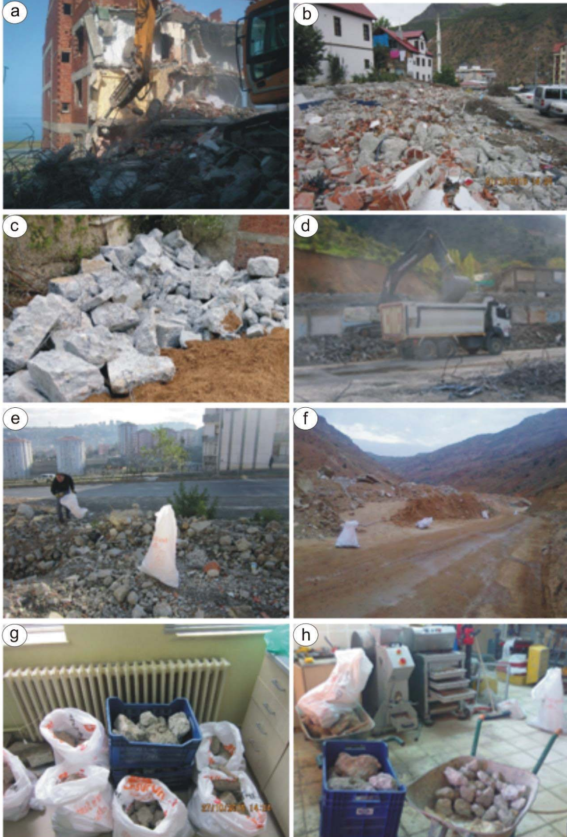
Şekil 2.3. İnşaat atıklarının alınması a, b, c) Kentsel dönüşüm amaçlı binaların yıkılması ve moloz oluşumu, d, e, f) numunelerin laboratuvara getirilmesi g, h) boyut küçültme işlemine hazırlanması
