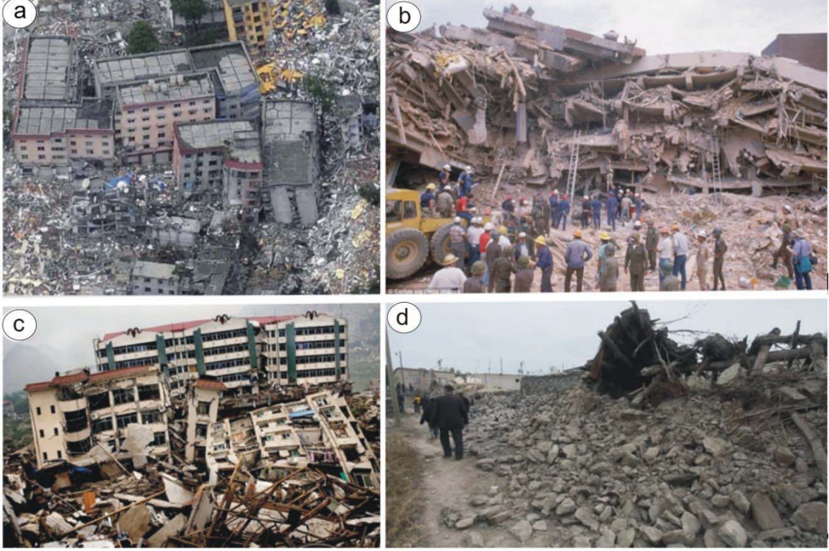
Şekil 1.2. Depremlerde oluşmuş bina molozları, a) 2008 Siçuan depremi, b) 2017 Meksika depremi, c, d) 2010 Yushu ve 2011 Yunnan depremi sonrası
