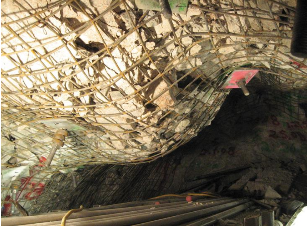
Şekil 1.6. Kaya patlaması yaşanan bir yeraltı açıklığı
