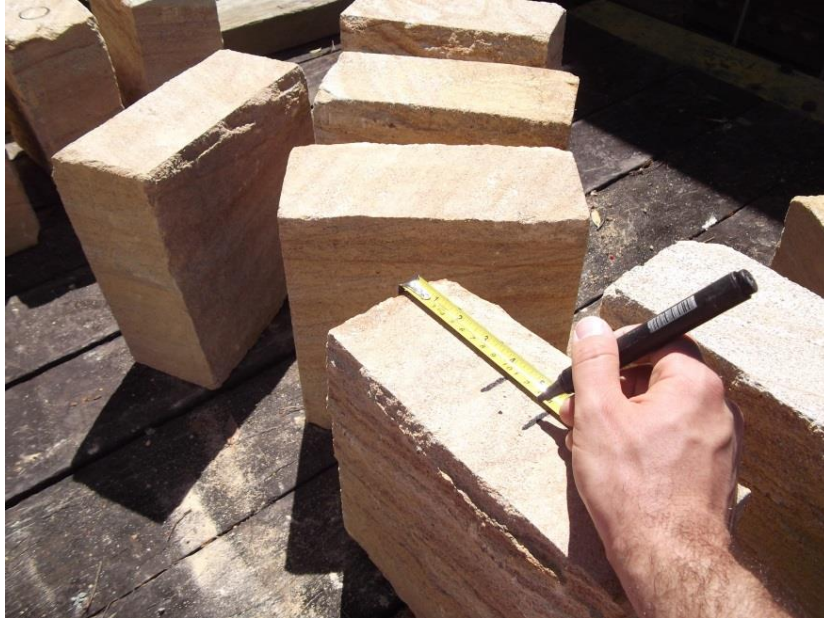
Şekil 2.4. Delik delinecek konumun bloklar üzerinde işaretlenmesi
