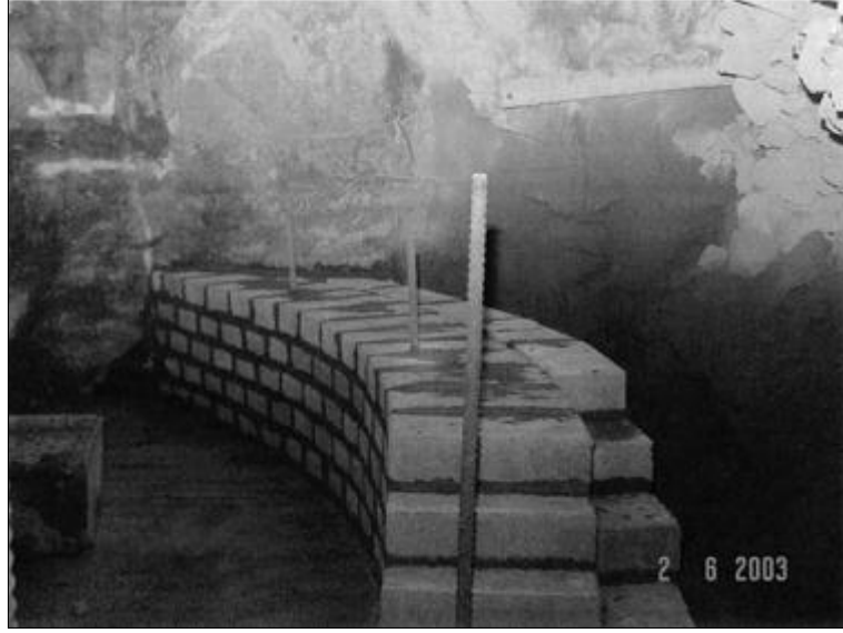
Şekil 1.2. Hidrolik dolgu barikadı (Sivakugan vd., 2006a).
